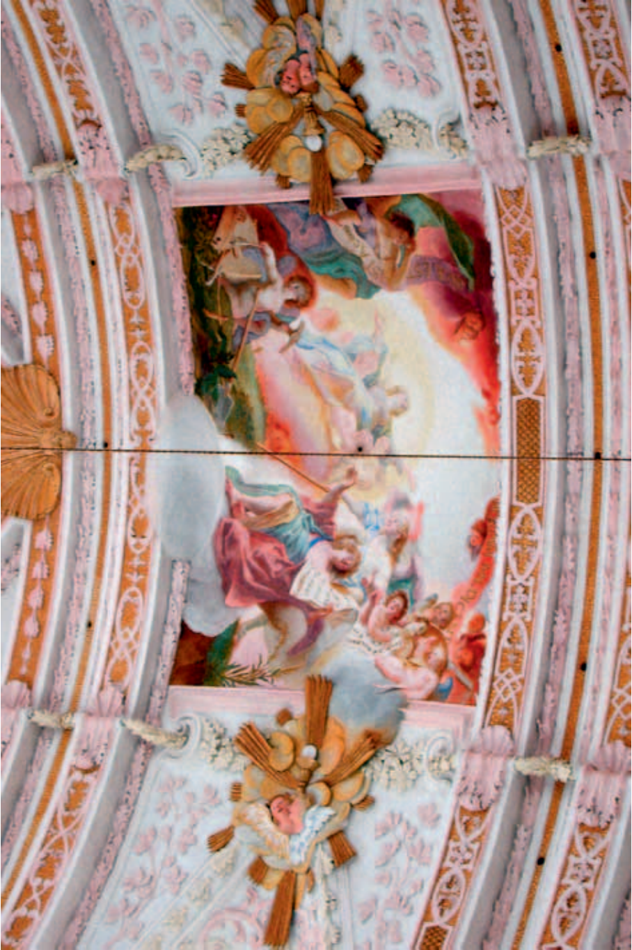
Abb. 35 Fürstentfeld, ehem. Zisterzienserkloster St. Maria Himmelfahrt, 4. Chorjoch
