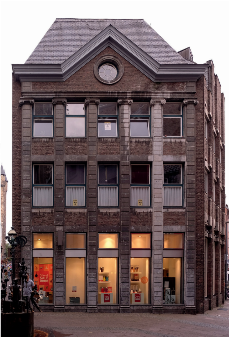
Abb. 3: Das erste Beispiel einer originalgetreu translozierten Fassade in Aachen. Hof 20 mit der wiedererrichteten Fassade, Peterstraße 49, erbaut 1964 (2015).
