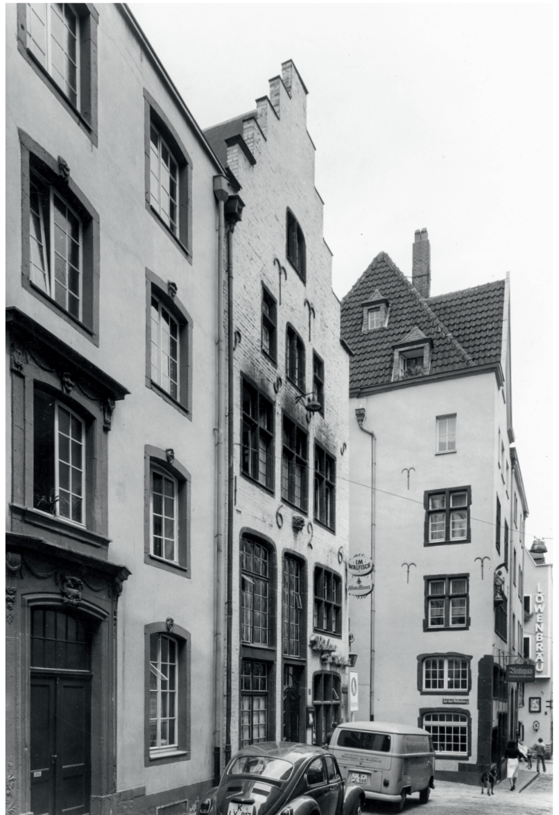
Abb. 1: Stadtsanierung der 1930er, mit dem translozierten Haus Salzgasse 13, Köln Martinsviertel. Das Stufengiebelhaus stammt aus der Tipsgasse. Durch die Einfügung und die Beibehaltung des anderen Eckhauses wurde eine einheitliche Typologie hergestellt (1970).
