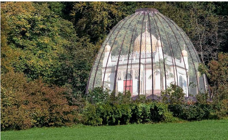
Abb. 4: Maurischer Kiosk, Temporäre Einhausung, Variante mit Kuppel-Ellipsoid, Prinzip Zitronenpresse mit transluzenter Membran (2019).
