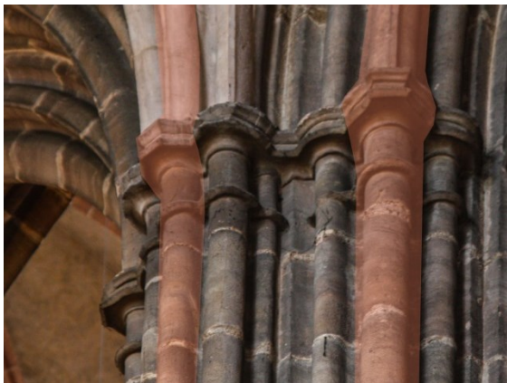
Abb. 4: Kapitell- bzw. Kämpferzone des Pfeilers mit Übergang von Pfeilerschaft zu den zugehörigen Gewölbebögen, Nöbauer 2019
