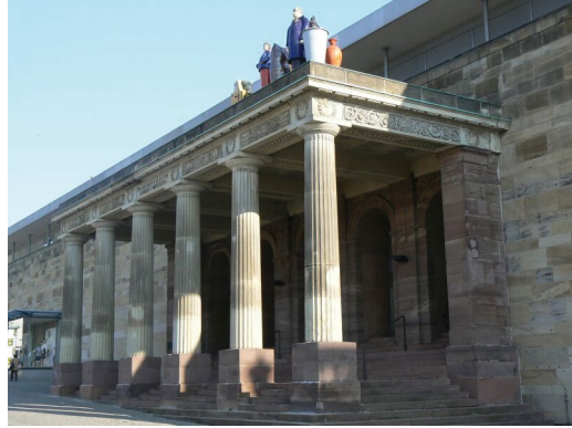
Abb. 18 Johann Conrad Bromeis, Sandsteinportikus des ehemaligen Roten Palais (1821-1826), heute vor einem Kaufhaus
