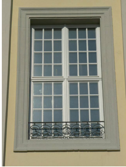
Abb. 34 Museum Fridericianum, schmiede- eisernes Gitter vor Fenstern im OG
