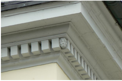
Abb. 27 Museum Fridericianum, Kassel, Gebälkdetail an rechter Fassadenecke
