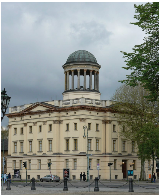
Abb. 103 Friedrich August Stüler, ehemalige Gardes du Corps Kaserne, 1851–1859, Berlin-Charlottenburg
