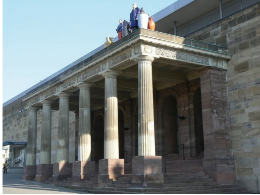
Abb. 18 Johann Conrad Bromeis, Sandsteinportikus des ehemaligen Roten Palais (1821-1826), heute vor einem Kaufhaus
