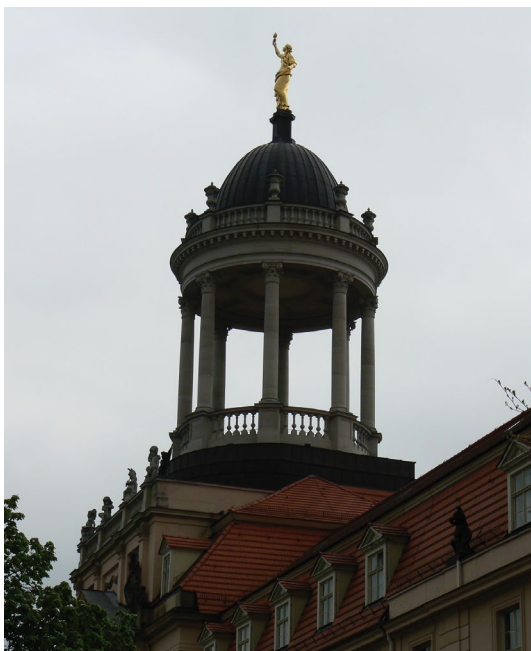
Abb. 101 Blick auf die Waisenhaus-Kuppel des Militärwaisenhauses von Carl von Gontard, nach Kriegszerstörungen 1999/2000 wiedererrichtet.
