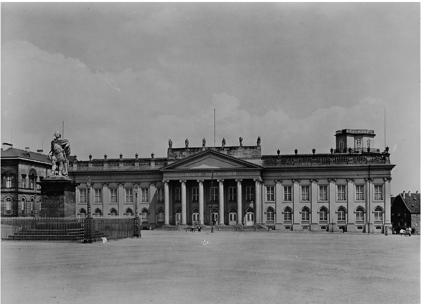
Abb. 17 Kassel, Museum Fridericianum und Landesbibliothek, Gesamtansicht, Aufnahme vor 1938, © Bildarchiv Foto Marburg
