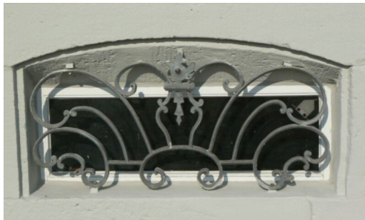
Abb. 35 Museum Fridericianum, schmiedeeisernes Gitter vor Kellerfenstern
