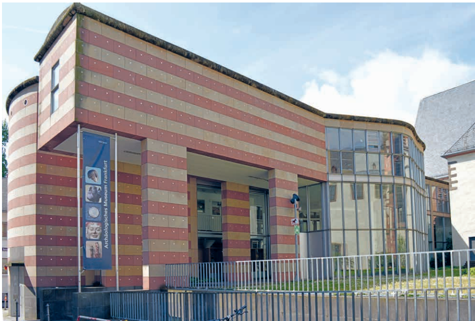
Abbildung 140. Archäologisches Museum, Ansicht der Nordfassade von der Karmelitergasse
