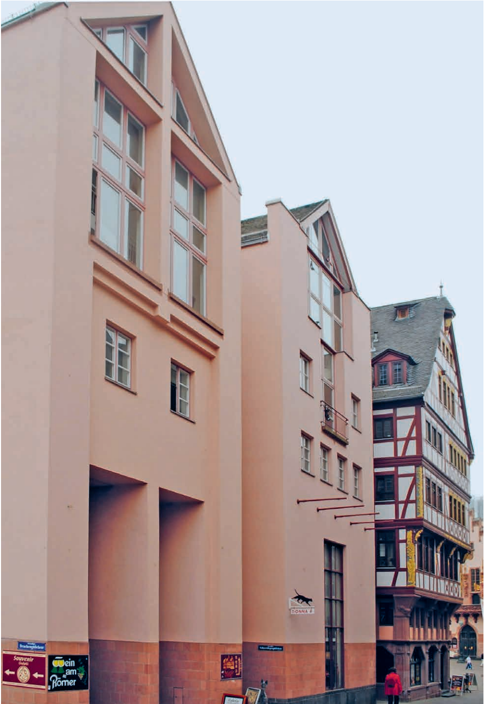
Abbildung 36. Anschlussbauten der Ostzeile, Ansicht von Norden
