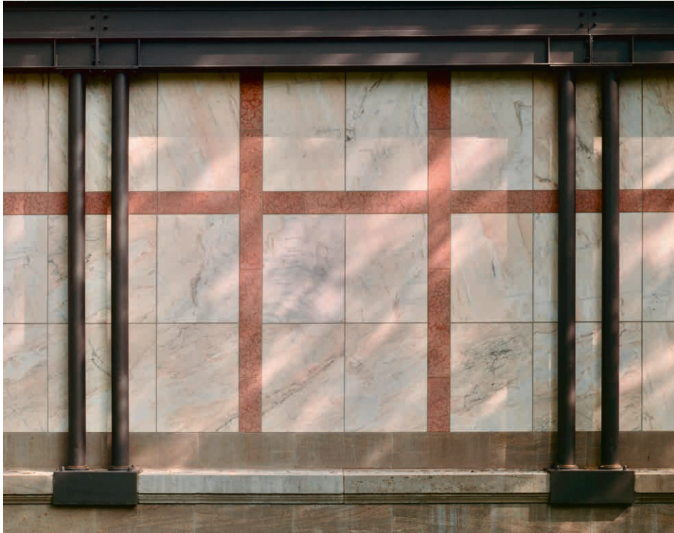
Abbildung 147. Erweiterung des Liebieghauses, Nordfassade (Detail)
