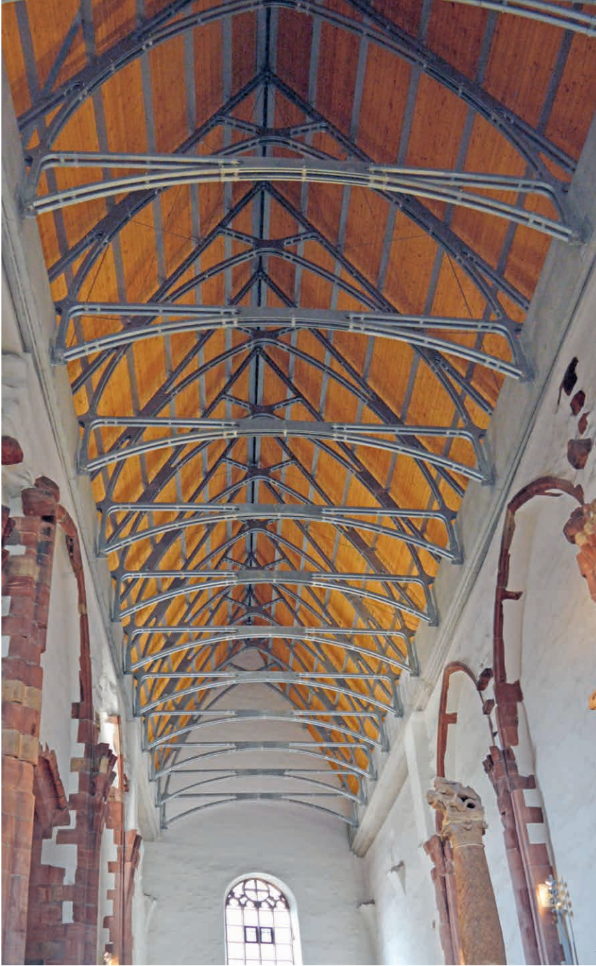
Abbildung 142. Ehem. Karmeliterkirche, Blick in den Dachstuhl
