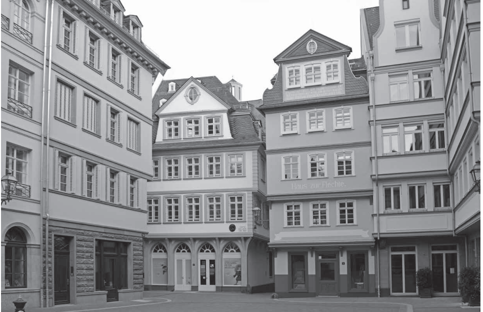
Abbildung 66. »Neue« Altstadt Frankfurt, Häuser am Hühnermarkt, 2018
