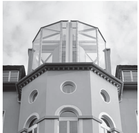
Abbildung 126. Jüdisches Museum, Ansicht des Treppenhauses von außen, um 1989
