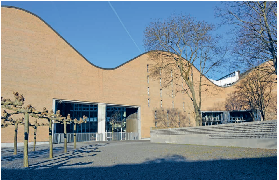
Abbildung 99. Ehem. Kundenzentrum der Stadtwerke, Ostseite am Börneplatz
