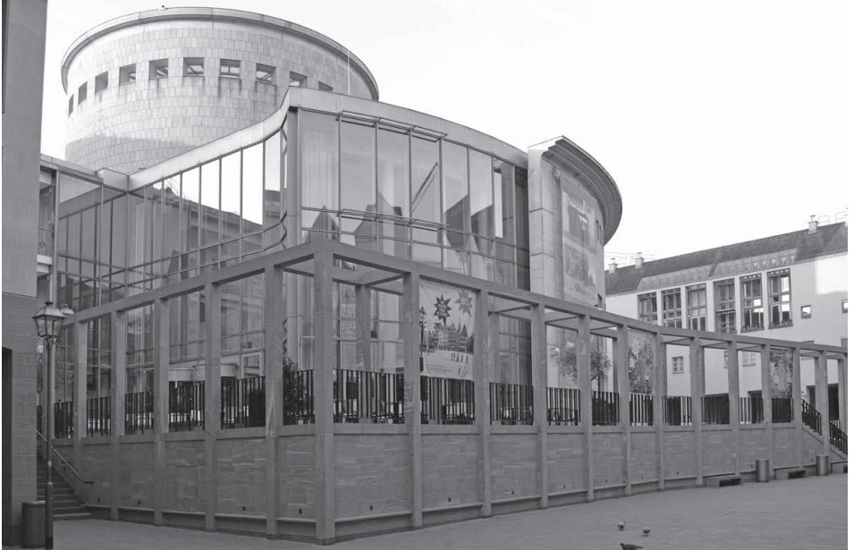
Abbildung 37. Blick auf die Rotunde der Schirn von Norden mit Pergola der »neuen« Altstadt
