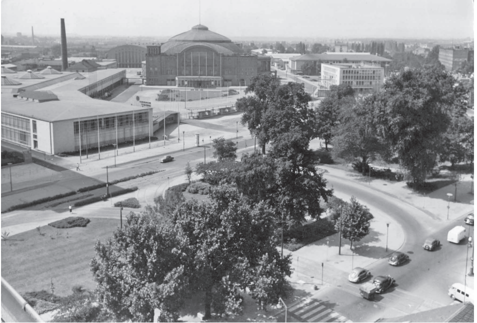
Abbildung 188. Blick vom Platz der Republik auf das Messegelände mit Festhalle (Mitte), Halle 3 (hinten links) und Kongresshalle (hinten rechts), um 1953
