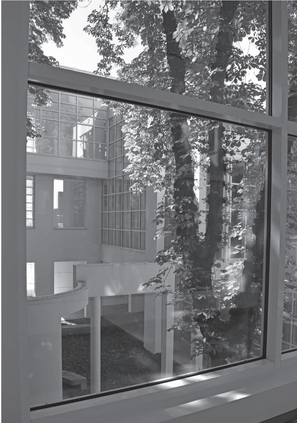
Abbildung 172. Erweiterung des Museums für Kunsthandwerk, Blick vom Ausstellungsraum in den Innenhof
