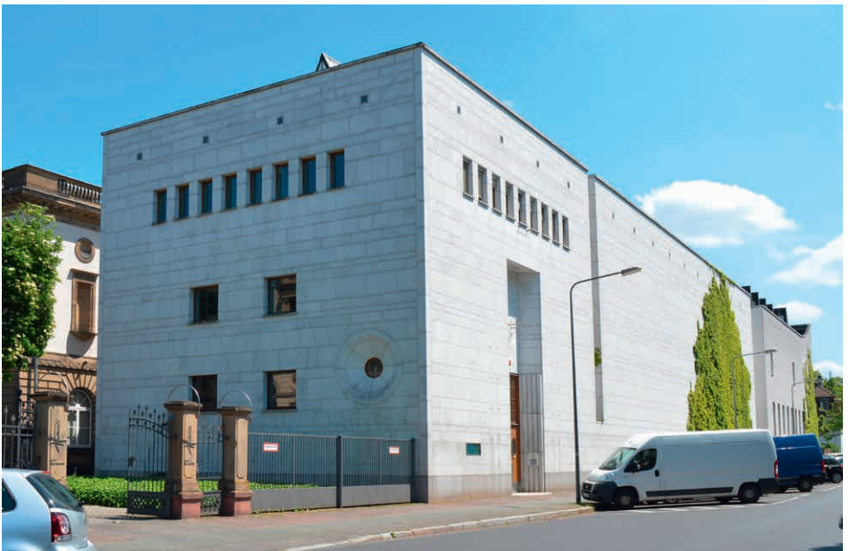
Abbildung 129. Erweiterungsgebäude des Städel Museums, Ansicht von der Holbeinstraße
