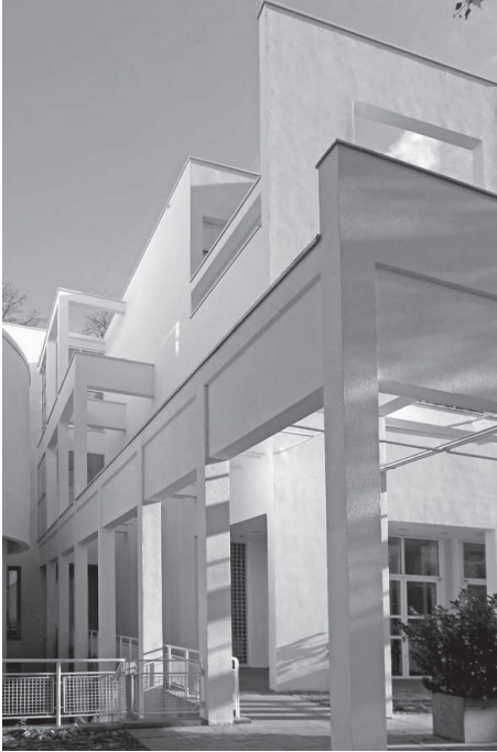
Abbildung 176. Erweiterung des Museums für Kunsthandwerk, Eingang der Parkseite
