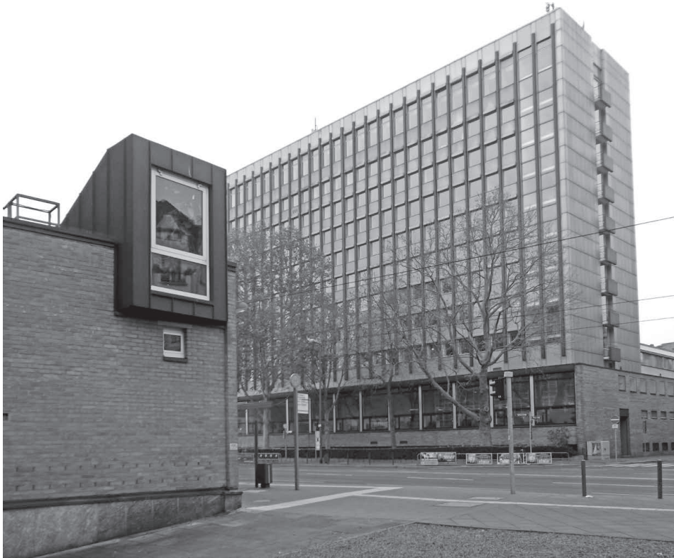
Abbildung 97. Ehem. Kundenzentrum der Stadtwerke (links) mit Blick auf das gegenüberliegende AOK-Gebäude
