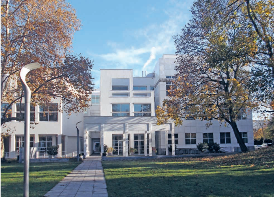
Abbildung 175. Erweiterung des Museums für Kunsthandwerk, Westfassade, Ansicht vom Park
