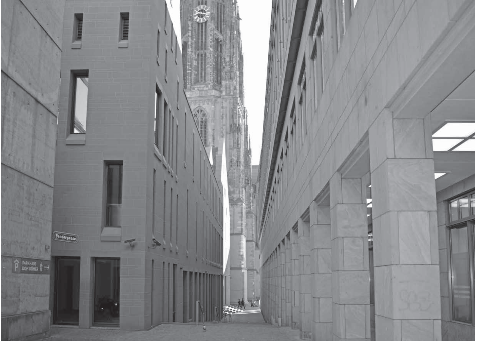
Abbildung 35. Fußweg zwischen Schirn (rechts) und Stadthaus (links)
