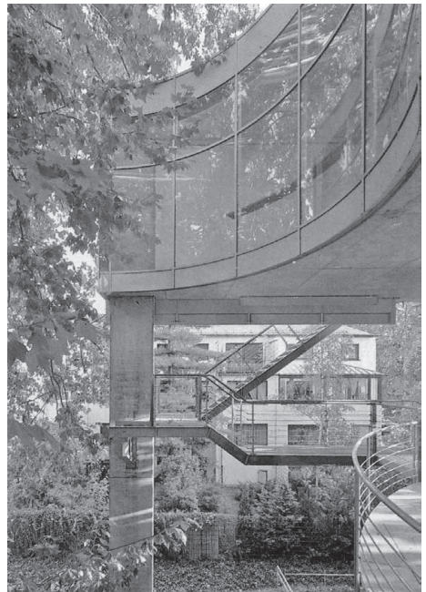
Abbildung 184. Erweiterungsbau des Postmuseums, Ostfassade (Detail)
