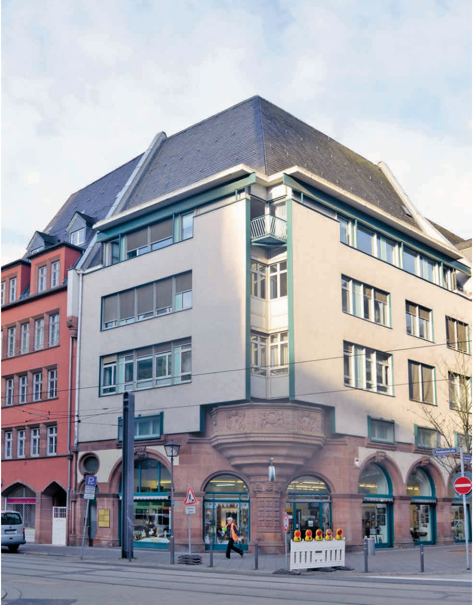
Abbildung 70. Haus Braubachstraße 10, 1906, Wiederaufbau 1986
