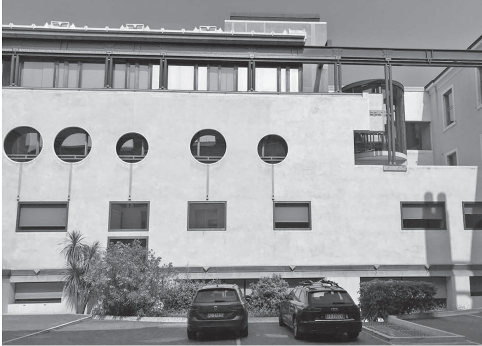
Abbildung 154. Carlo Scarpa, Banca Popolare, Verona, 1973, Fassade zum Innenhof
