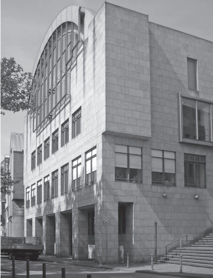
Abbildung 32. Seitentrakt der Schirn Kunsthalle, Ansicht von der Saalgasse
