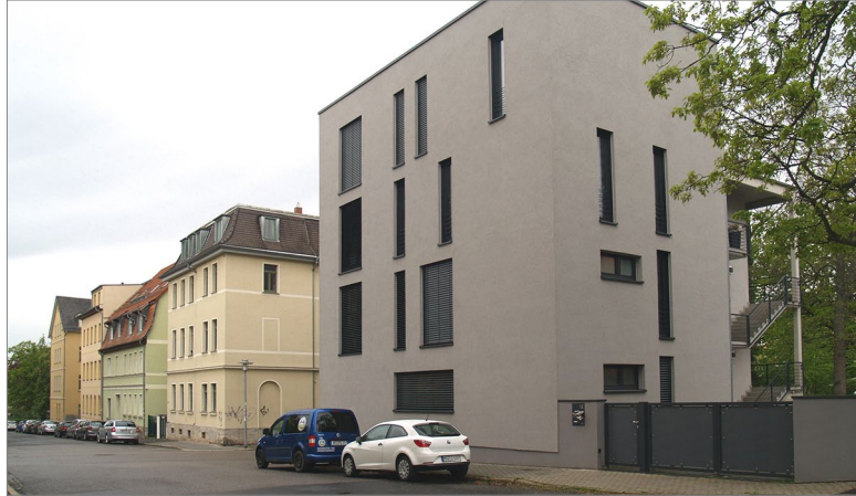
Abb. 11: Blick in die Brennerstraße mit Neubau.
