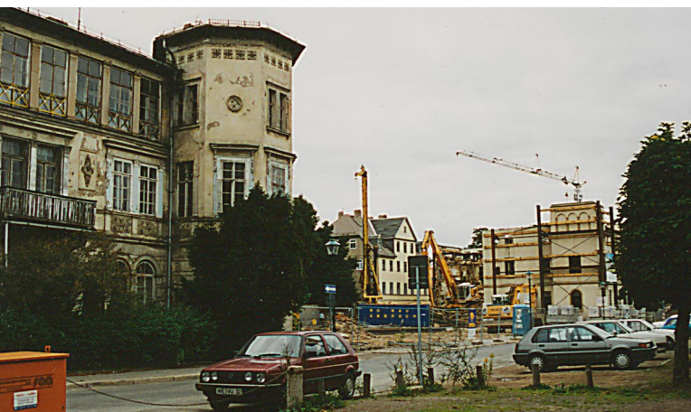
Abb. 4: Westseite des Beethovenplatzes mit Baulücke (kriegszerstörte Weimarsche Bank) und Zöllnerschem Wohnhaus, 1996, ab 1998 dort Neubau des Dorint-Hotels unter Einbeziehung der Fassadenrekonstruktion.
