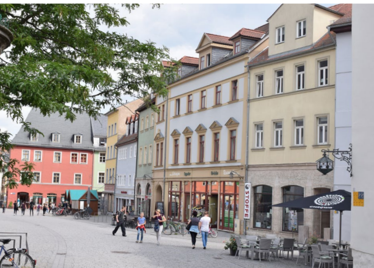
Abb. 12: Blick aus der Straße Eisfeld auf die Südseite des Platzes, 2018.
