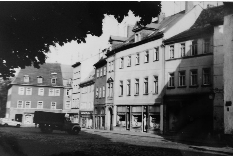
Abb. 11: Blick aus der Straße Eisfeld auf die Südseite des Platzes, 1985.
