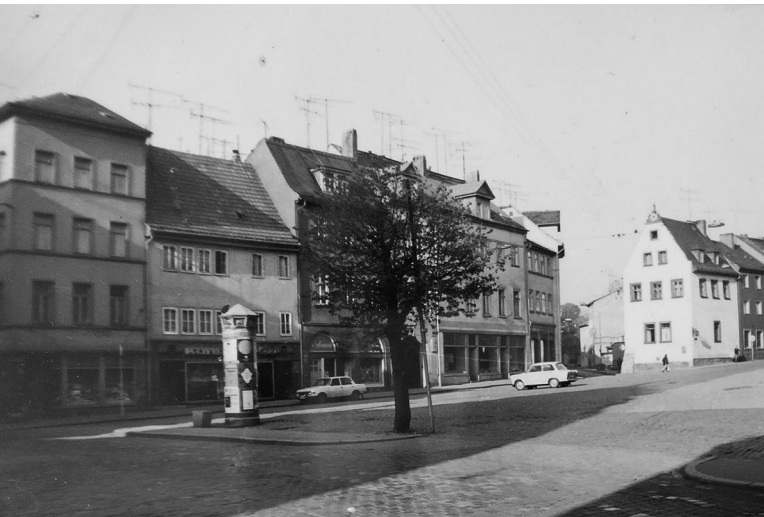
Abb. 1: Blick von der Jakobstraße auf die Südseite des Platzes und den Sächsischen Hof, 1980.
