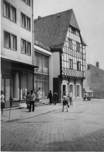
Abb. 9: Löschhaus mit angrenzender filigran modernistisch gestalterer Weimarinformation, Marktstraße, 1975.
