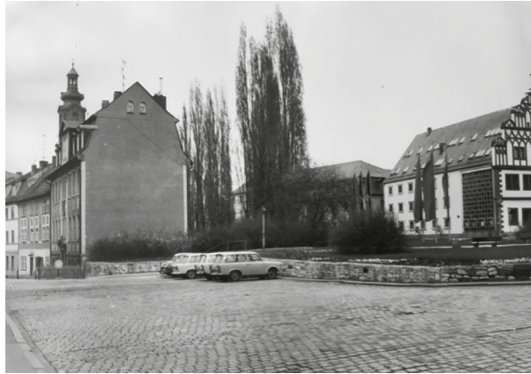
Abb. 2: gleiche Ansicht, nach der Kriegszerstörung und Beräumung, 1986.
