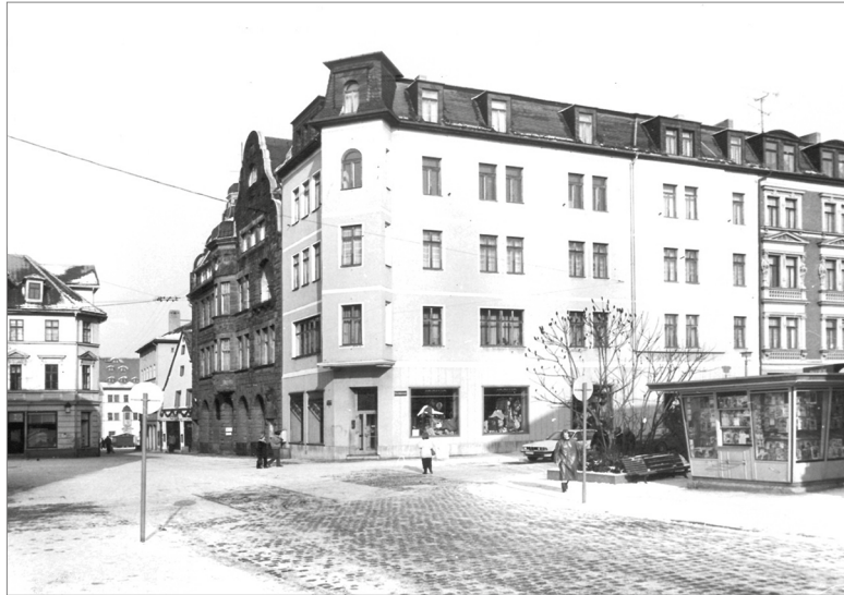
Abb. 5: Städtebauliche Situation vor dem Neubau des Sparkassengebäudes 1991 sowie vor der Fassadenrekonstruktion am Haus Puschkinstr. 1 im Jahr 2014.
