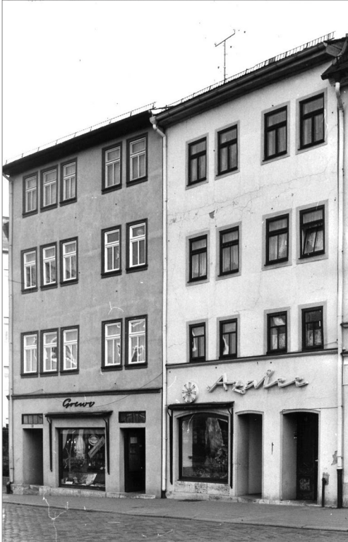
Abb. 7: Die Häuser Frauentorstr. 13/15 sind im Jahr 1991 augenscheinlich in solidem Zustand, im Bestandsplan allerdings als dringend sanierungsbedürftig gekennzeichnet.
