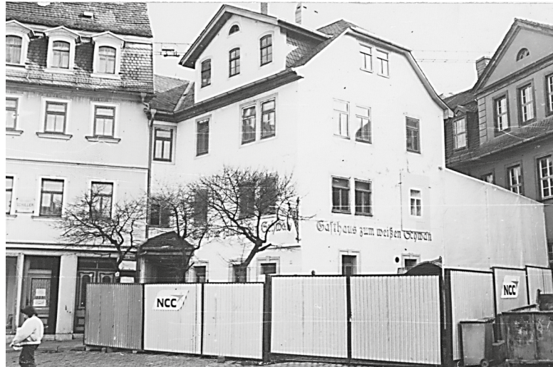
Abb. 2: Das „Gasthaus zum weißen Schwan“ um 1989 zu Beginn der Sanierungsarbeiten.
