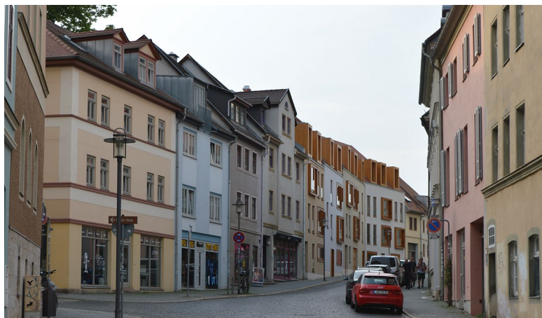
Abb. 13: Historisches Gebäude der Jakobstraße 29 mit anschließenden Neubauten Jakobstraße 29a-41, 2018.
