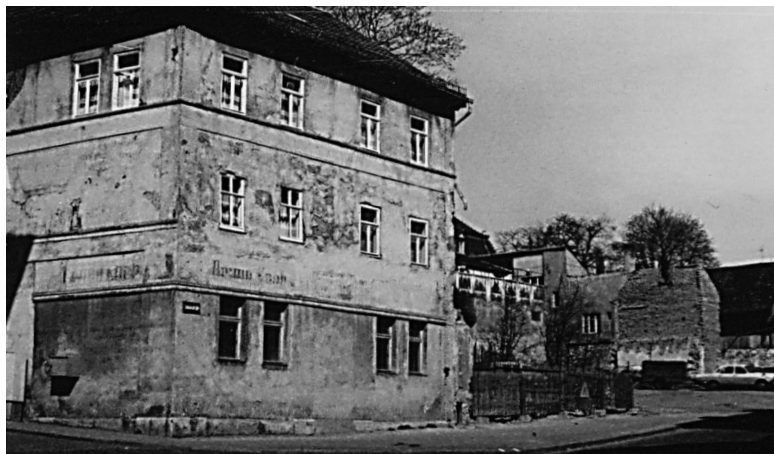
Abb. 12: Eckhaus der Jakobstraße 29 nach dem Abriss der Häuser 29a-41, 1982.
