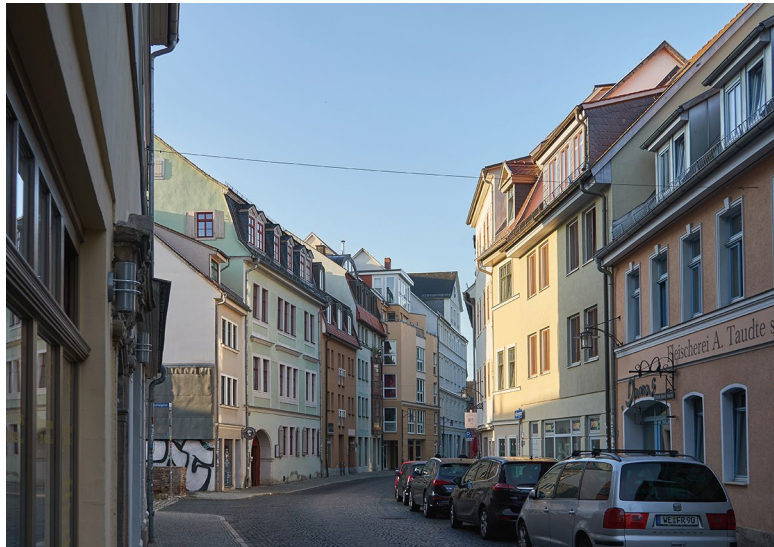
Abb. 3: v.l.n.r.: Baulücke Luthergasse 2, grau Jakobstraße 12, hellgrün Jakobstraße 10, orange bzw. grün bzw. hellorange Neubauten Jakobstraße 4-8; v.r.n.l.: orange Jakobstraße 11, hellgrün Neubau Jakobstraße 9, graugelb/hellblau Doppelhaus Jakobstraße 5/7.
