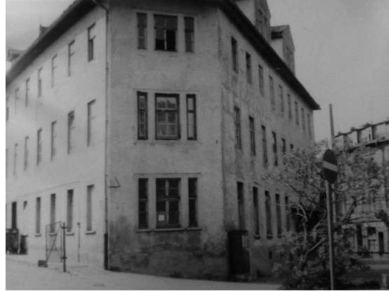
Abb. 2: Gebäude Friedensstraße 2, Ecke Friedensstraße/Rollgasse gesehen aus der Friedensstraße, 1988.
