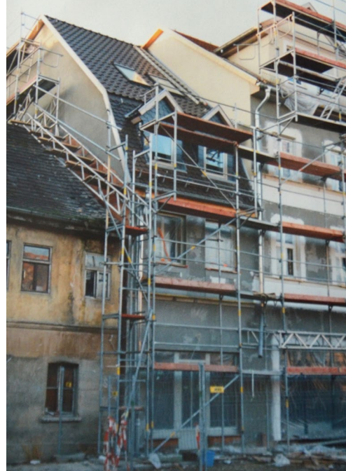
Abb. 5: Gebäude Rollgasse 13/Friedensstraße 2, fotografiert aus der Rollgasse, November 1995.
