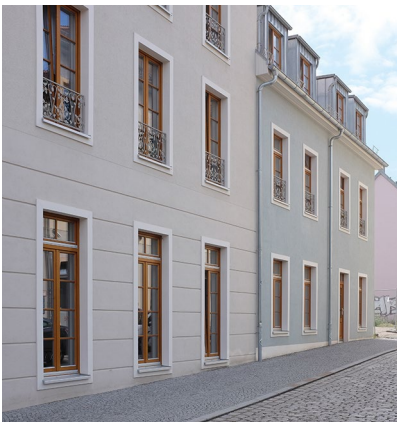
Abb. 9: Gebäude Friedensstraße 4, Fassade zur Rollgasse, Juni 2018.
