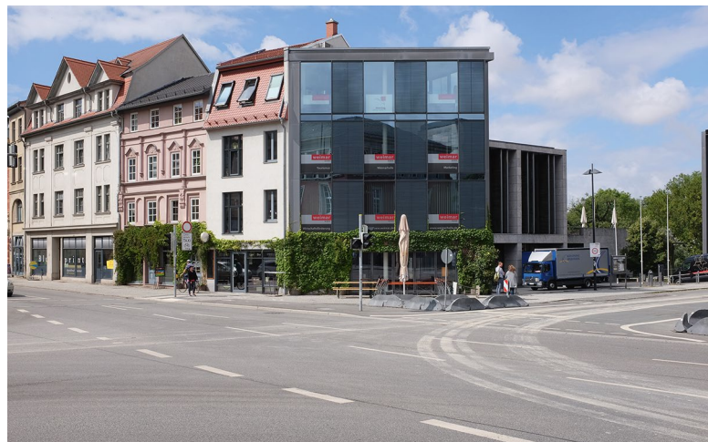
Abb. 6: Blick auf die Häuser Karl-Liebkecht-Str. 25-27, im Hintergrund die Neue Weimarahalle, Juni 2018.
