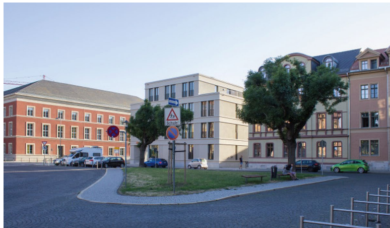
Abb. 15: Rathenauplatz, Blick aus nordöstlicher Richtung, mit Neubau von 2014, 2018. Auffällig ist auch die veränderte Farbgebung und die entfernten Dachfenster am Haus 2 des ehemaligen Gauforums. Am Gebäude nördlich des Neubaus wurden im Zuge der Sanierung Dachgauben hinzugefügt. Auch bei diesen Gebäuden veränderte sich die Farbgebung nach der Sanierung.
