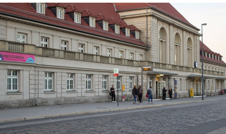
Abb. 6: Bahnhofsgebäude, Fassade zum Bahnhofsvorplatz nach der Sanierung, 2018. Am auffälligsten ist die Wiederherstellung der hellen Farbgebung, doch auch die Wiederherstellung der steinernen Brüstung ist gut zu erkennen.
