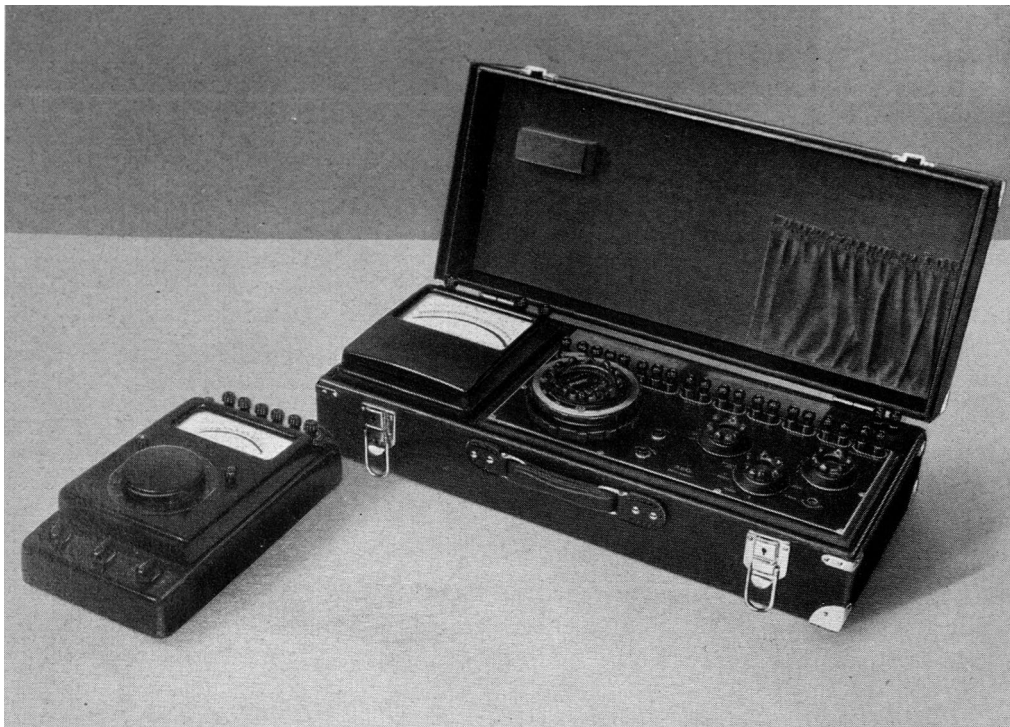
Alter und neuer Vektormesser der AEG, AEG-Mitteilungen 1953
