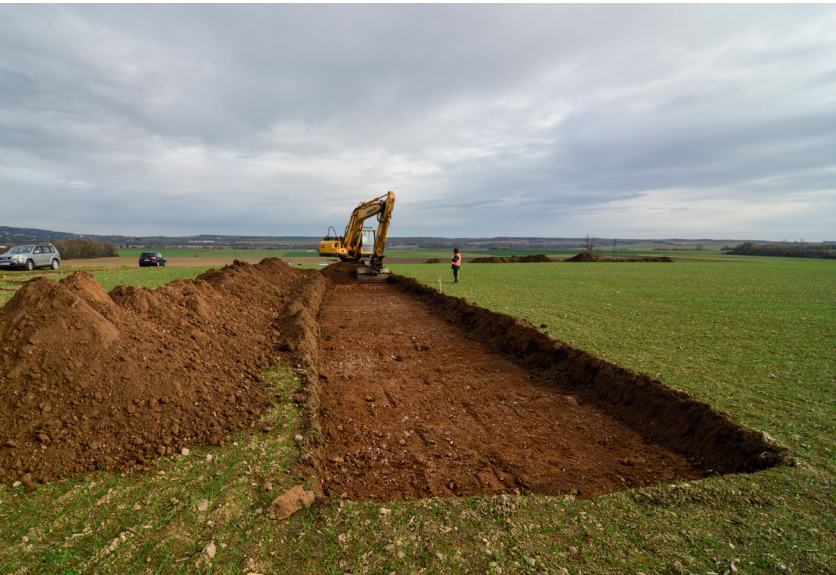
Abb. 2: Maschinelles Abziehen der Humusschicht auf der Verdachtsfläche (2017).
