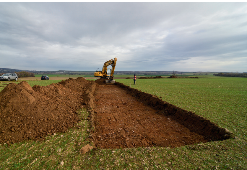
Abb. 2: Maschinelles Abziehen der Humusschicht auf der Verdachtsfläche (2017).
