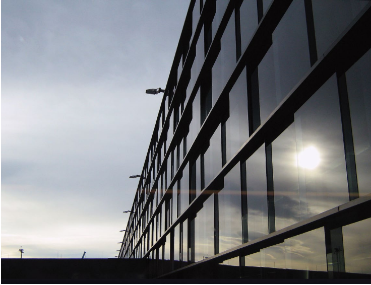
Abb. 2 VIE, Terminal 3, Luftseite, 23.4.2012.
