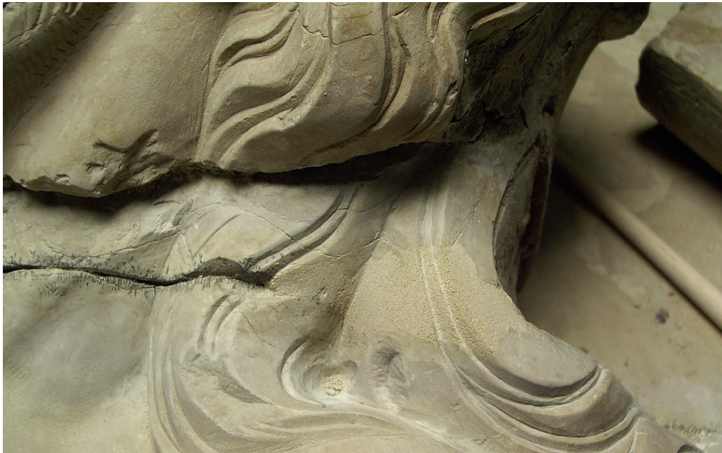
Abb. 8 Kruzifix, Kopfdetail, Zustand während des Kittens der Ansatzfuge
