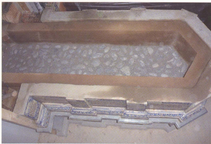
Abb. 3 Der Kachelofen während des Aufbaus: Die mit Lehm verputzten Kieselsteine im Inneren des Ofens bilden eine Speicherschicht unter dem Feuerraum, auf welche im nächsten Schritt die Feuerplatten für den Feuerraum gesetzt werden; nach außen folgt eine Füllschicht aus Erzsteinen; an der Außenfläche des Ofens sind die mit Schamottesteinen und Lehm gesetzten Kacheln sichtbar
