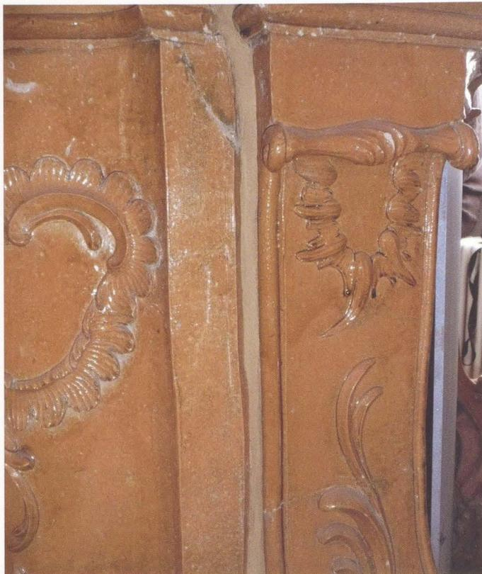
Abb. 9 Die eingefärbten Fugenfüllungen aus Polyethylenschaumstoff
