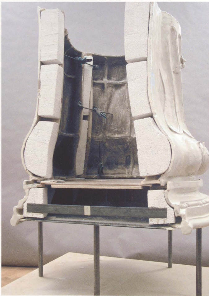
Abb. 12 Zusammenbau der Kachelreihen zu relativ leichten und einfach zu transportierenden Elementen
