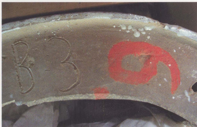
Abb. 6 Originale Ritzung des Herstellers und nachträgliche Beschriftung, vermutlich 1898 im Rahmen der Demontage der Öfen in Schloss Hof
