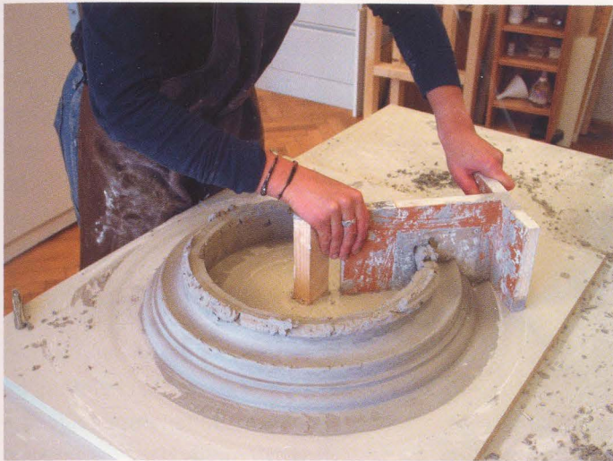
Abb. 11 Rekonstruktion des Profilrings, Herstellung eines Positivs aus Gips mit einem Profilhobel
