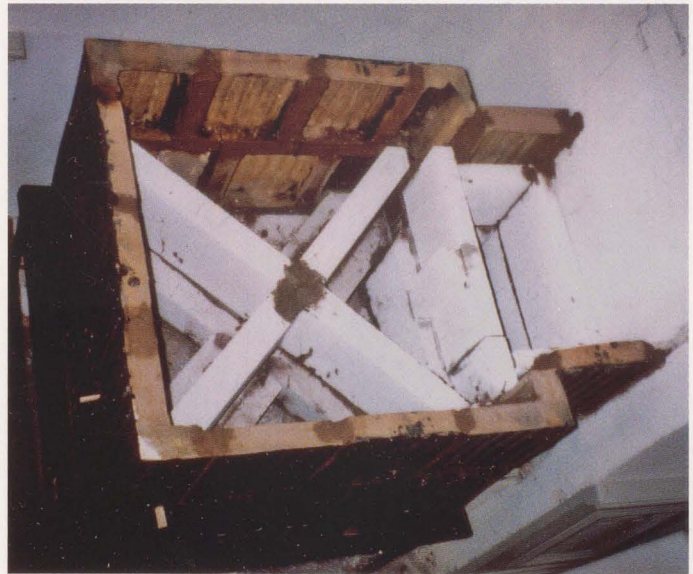
Abb. 7 Innere Stützkonstruktion aus Ytongplatten zum musealen Aufbau des Kachelofens: Ansicht von oben in den unvollendet gesetzten Ofen
