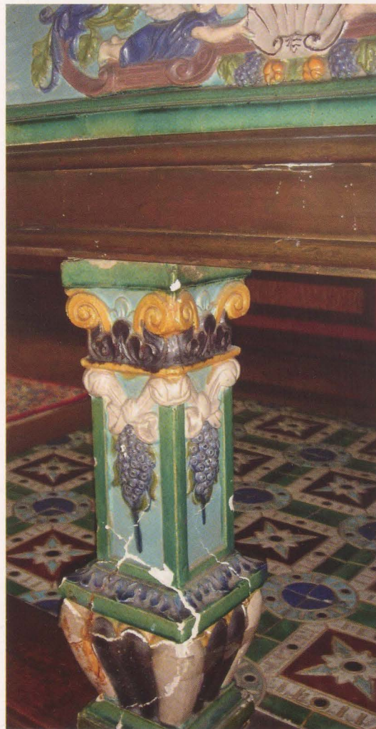
Abb. 5: Spannungsrisse an den Ofenbeinen durch Überlastung. Schloss Vornbach, Niederbayern
