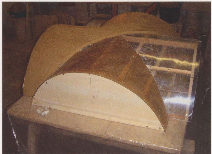
Abb. 7 Der Bau des Baldachingewölbes in Überschlagtechnik
