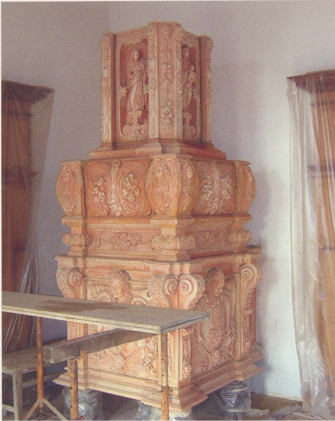
Abb. 9 Aufbau der gebrannten Ofenelemente ohne Baldachin vor der Grafitierung
