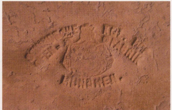
Abb. 6 Schloss Linderhof, Venusgrotte, Innenseite einer Blattkachel von Kachelofen Nr. 7 mit dem Stempel der Herstellerfirma „SCHMIDSCHES KGL. HOF-OFEN-FABRIK MÜNCHEN“
