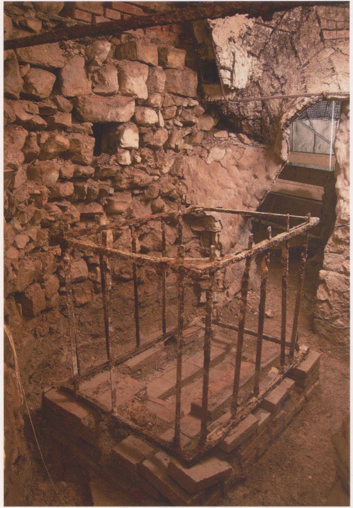
Abb. 4 Schloss Linderhof, Venusgrotte, Nische von Kachelofen Nr. 7 nach dem Abbau des Ofens; auf das erhaltene Ofenfundament wurde das Eisenskelett des Feuerraums gestellt
