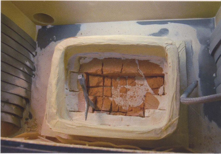
Abb. 2 Abnahme von Gips und Schamottestein aus einem Kachelstumpf
