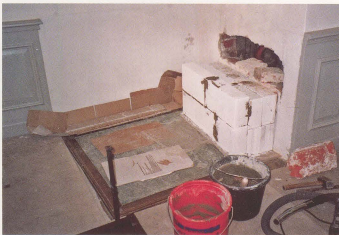
Abb. 5 Originaler Estrichboden mit Holzeinfassungen für den Ofen im ersten gräflichen Vorzimmer, Stadtresidenz Landshut
