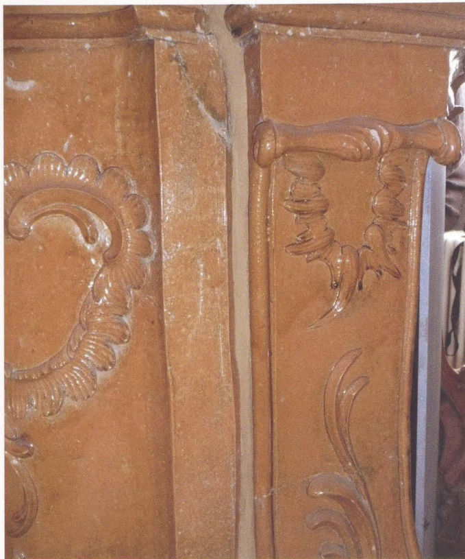
Abb. 9 Die eingefärbten Fugenfüllungen aus Polyethylenschaumstoff
