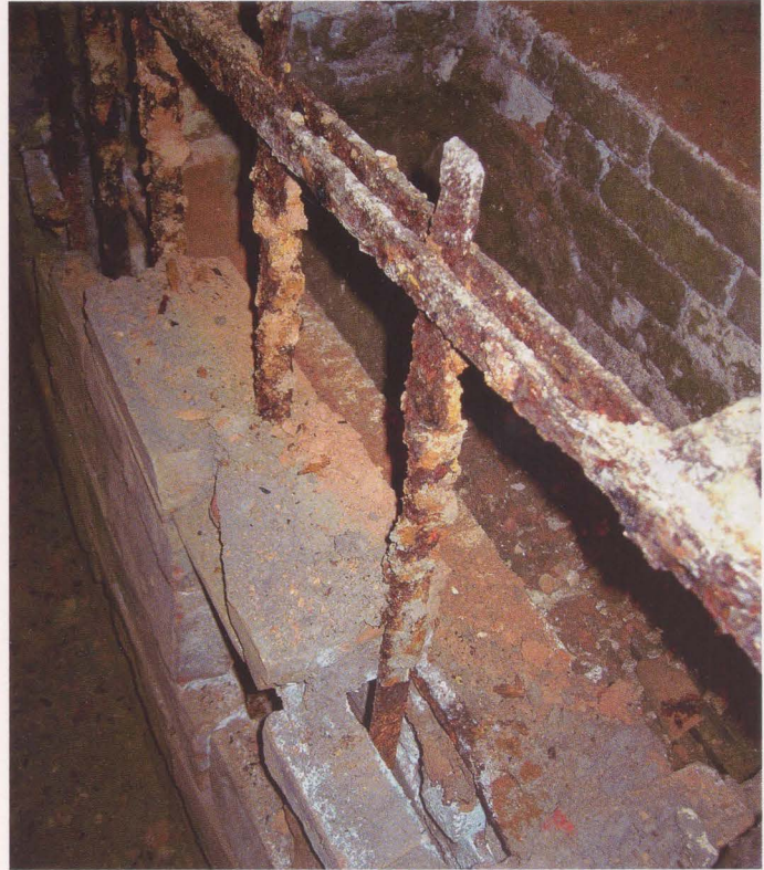
Abb. 14 Eisenkorsett um die Feuerung von Kachelofen Nr. 7
