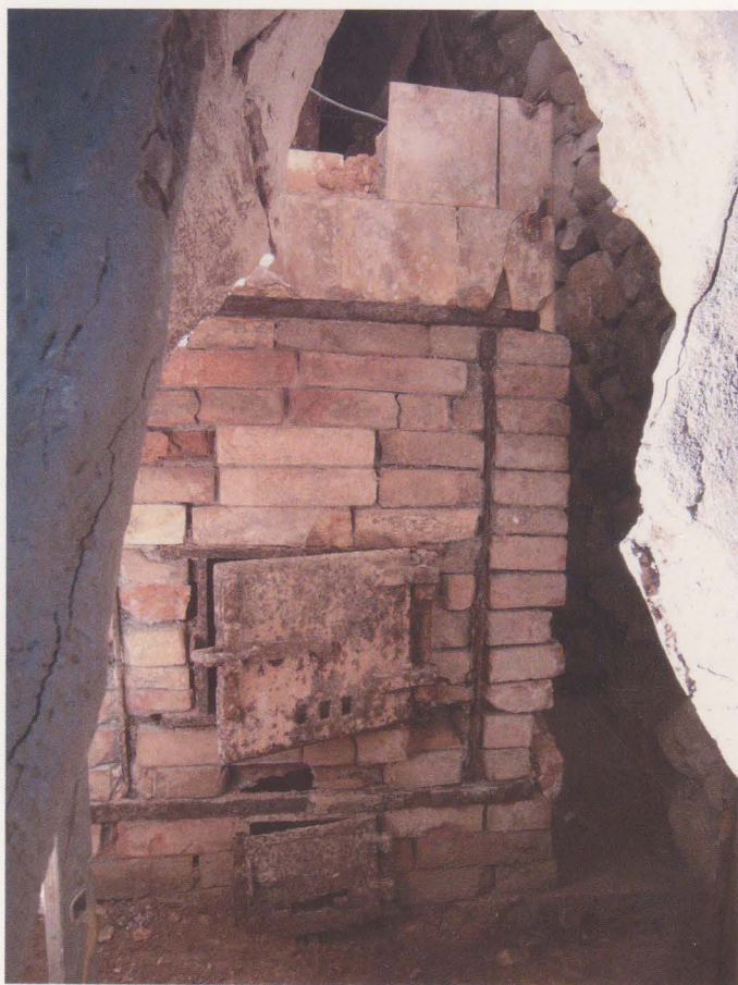
Abb. 7 Schloss Linderhof, Venusgrotte, Ofennische von Kachelofen Nr. 1, Blick von oben auf die Rückseite des Kachelofens vor dem teilweisen Abbau
