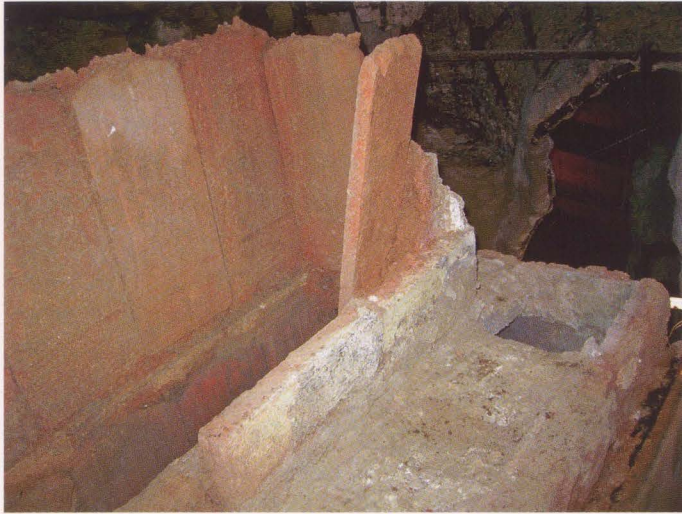
Abb. 13 Wärmeluftöffnung mit Biberschwanzdachziegel gemauert, rechts eine Umbrandöffnung vom 4. in den 5. Zug
