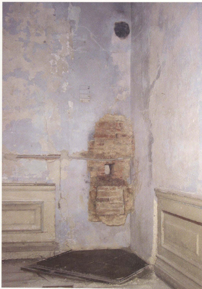
Abb. 8 Bautechnische Untersuchung im Schlafzimmer Maria Theresias in Schloss Hof zum Auffinden ehemaliger Befuerungs- bzw. Abgasöffnungen sowie ehemaliger Kaminöffnungen
