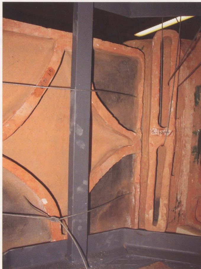
Abb. 7 Innenansicht des 5. Stockwerkes während des Aufbaus: Sicherungen mit Stahlseilen und -klammern an Stegen und Stahlgestell, Tonverfugung
