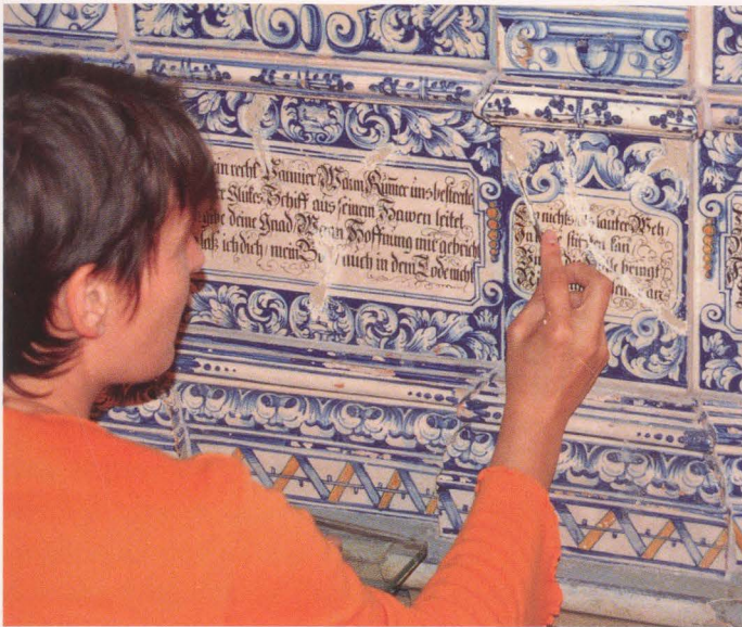
Abb. 5 Ergänzung fehlender Fragmente in der Glasur
