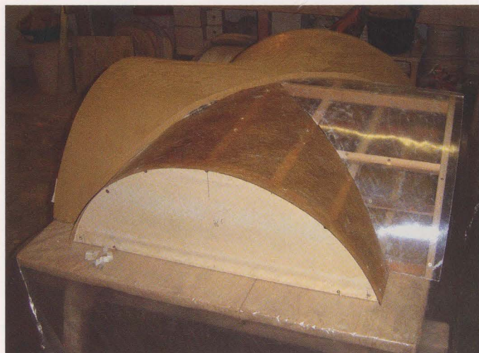
Abb. 7 Der Bau des Baldachingewölbes in Überschlagtechnik
