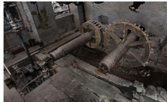
Abb. 4 Screenshot des 3D-Foto-Modells: Pumpenraum des Schwetzingen Wasserwerks
