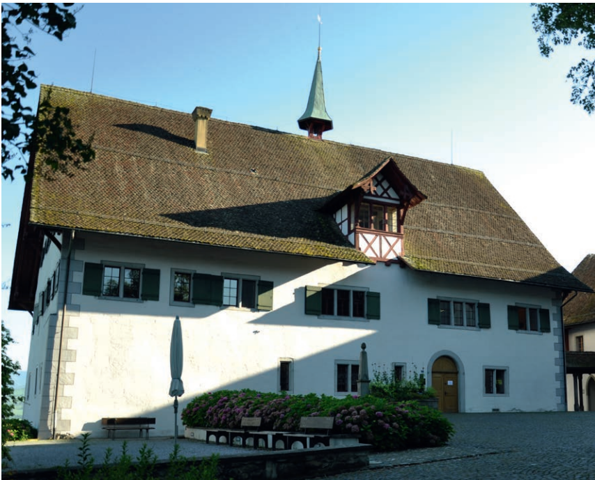
Abbildung 53. Amtshaus in Kappel am Albis, 1661 umgebaut, Nordfassade
