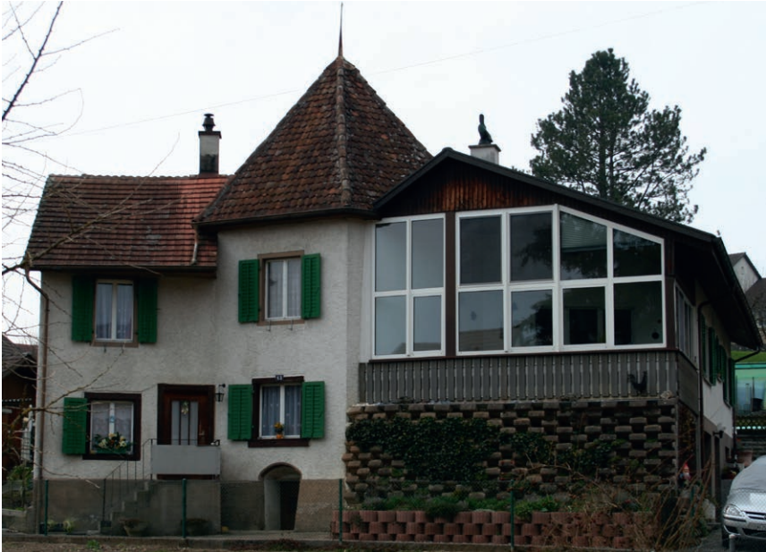
Abbildung 99. Herrensitz Oeschgen, ehem. Gartengebäude, wohl um 1597, Ansicht von Süden
