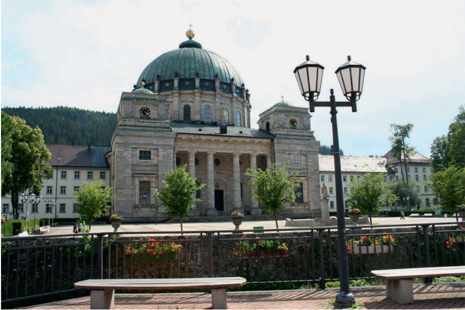
Abbildung 1. Hauptfassade der Klosterkirche St. Blasien und Teile der Klausur, Ansicht von Norden
