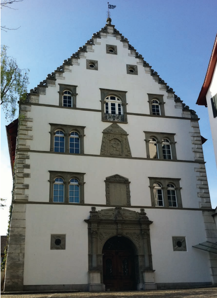
Abbildung 25. Zeughaus in Schaffhausen, 1617
