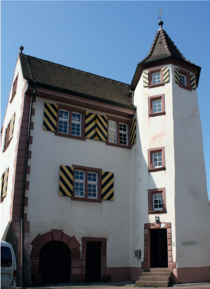
Abbildung 112. Meierhof Stetten, Ansicht von Osten
