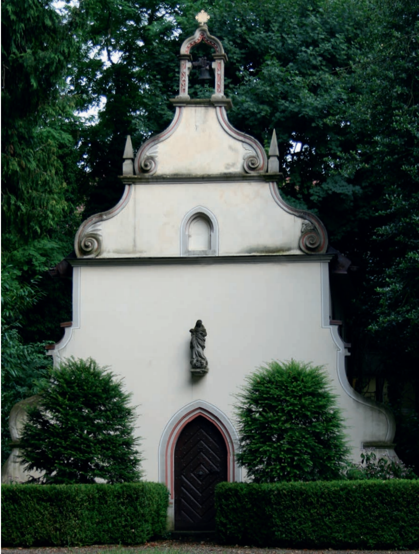
Abbildung 26. Propstei des Klosters St. Blasien in Krozingen, Kapelle, 1608, Ansicht von Westen
