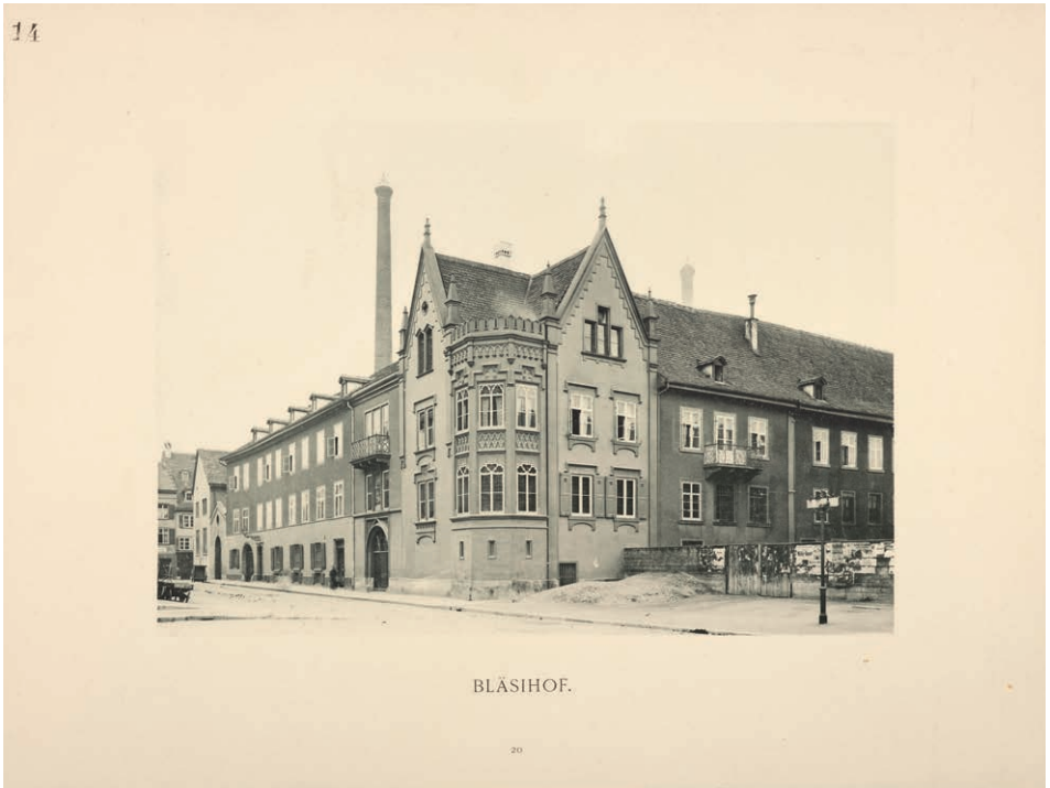
Abbildung 6. Stadthof des Klosters St. Blasien in Basel, Ansicht von Norden, ca. 1885
