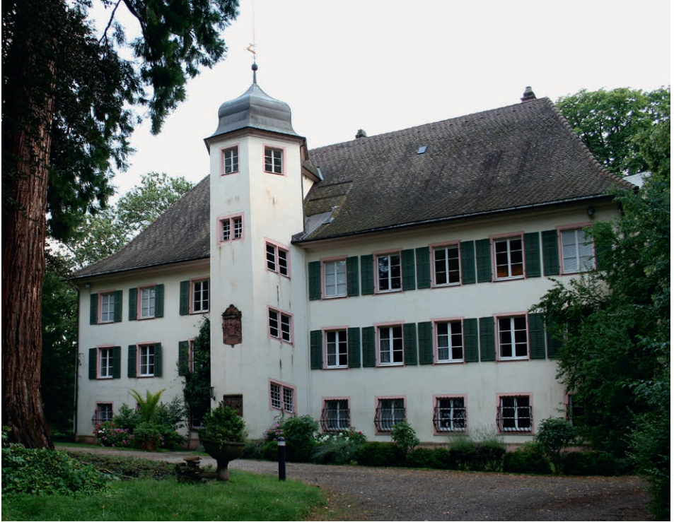
Abbildung 18. Propstei des Klosters St. Blasien in Krozingen, 1578/79 bzw. 1749/50, Ansicht der Hauptfassade von Norden
