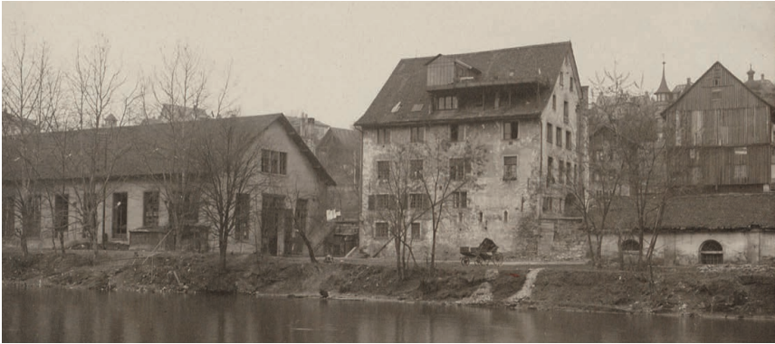
Abbildung 48. Amtshaus des Klosters St. Blasien in Zürich-Unterstrass, Ansicht von Westen
