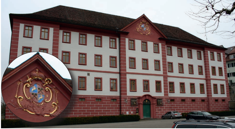
Abbildung 90. Propstei in Klingnau, Hauptfassade, Ansicht von Südosten
