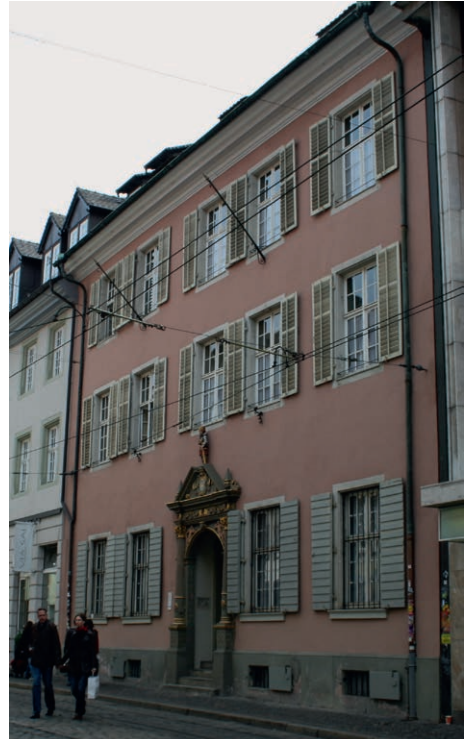
Abbildung 59. Stadthof des Klosters St. Blasien in Freiburg, Salzstr. 18, straßenseitige Fassade
