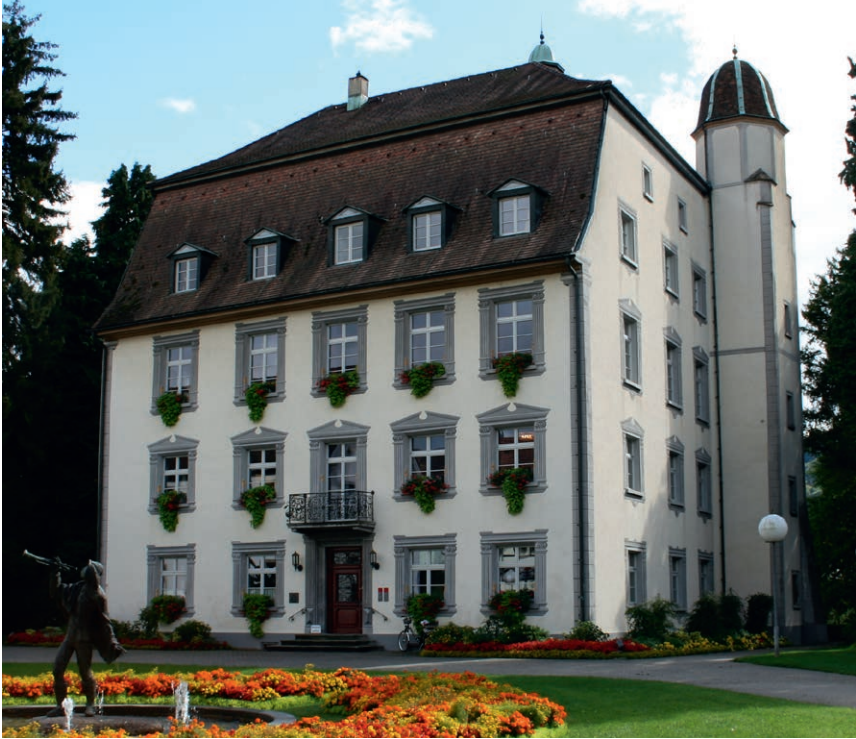
Abbildung 83. Stadthof der Familie v. Schönau in Bad Säckingen, Fassade wohl 1714–22, Ansicht von Norden
