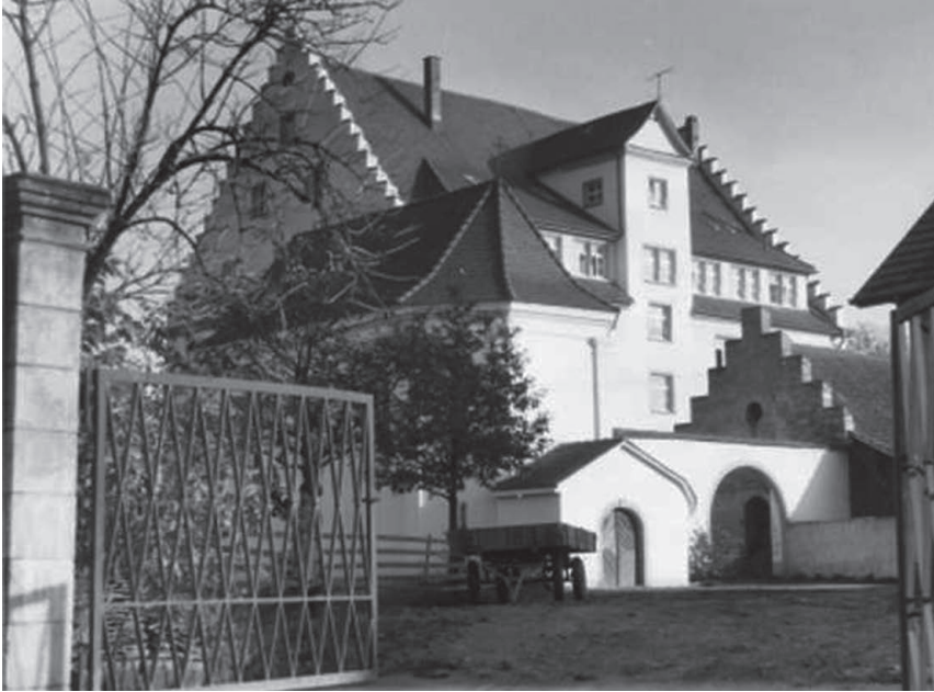
Abbildung 30. Propstei des Klosters St. Blasien in Gurtweil, 1662–65 bzw. 1. Hälfte 18. Jh., Ansicht von Nordwesten
