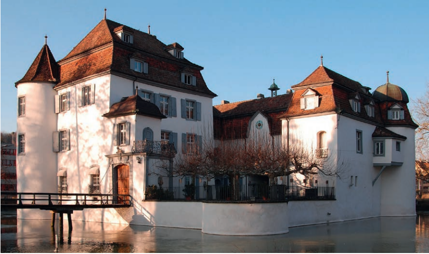
Abbildung 80. Schloss Bottmingen, Umbau 1720, Ansicht von Südosten
