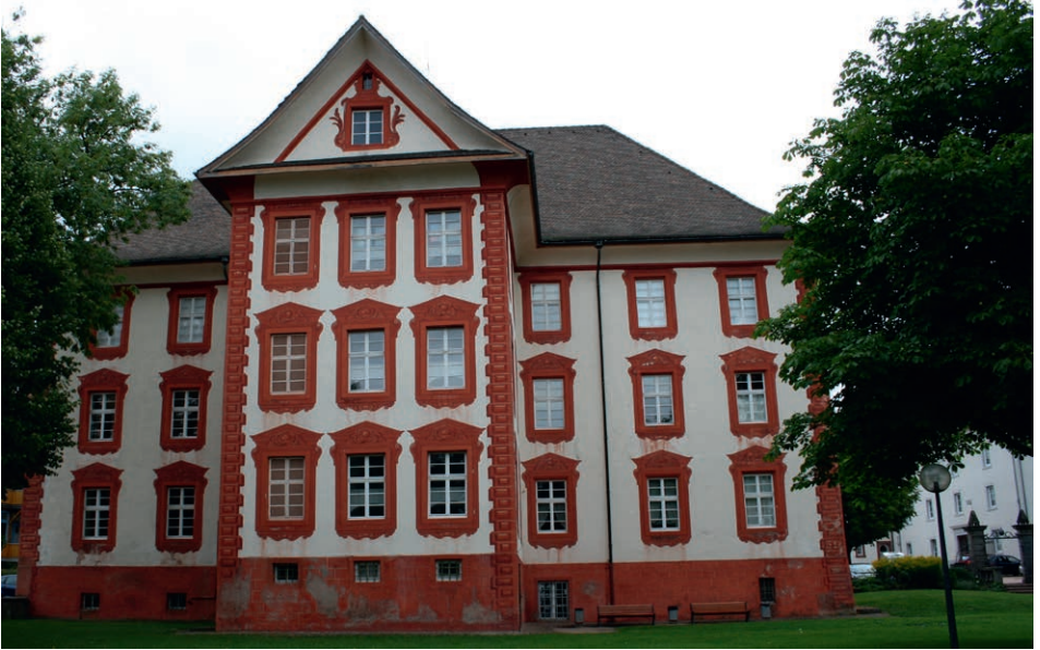
Abbildung 72. Schloss Bonndorf, Südfassade
