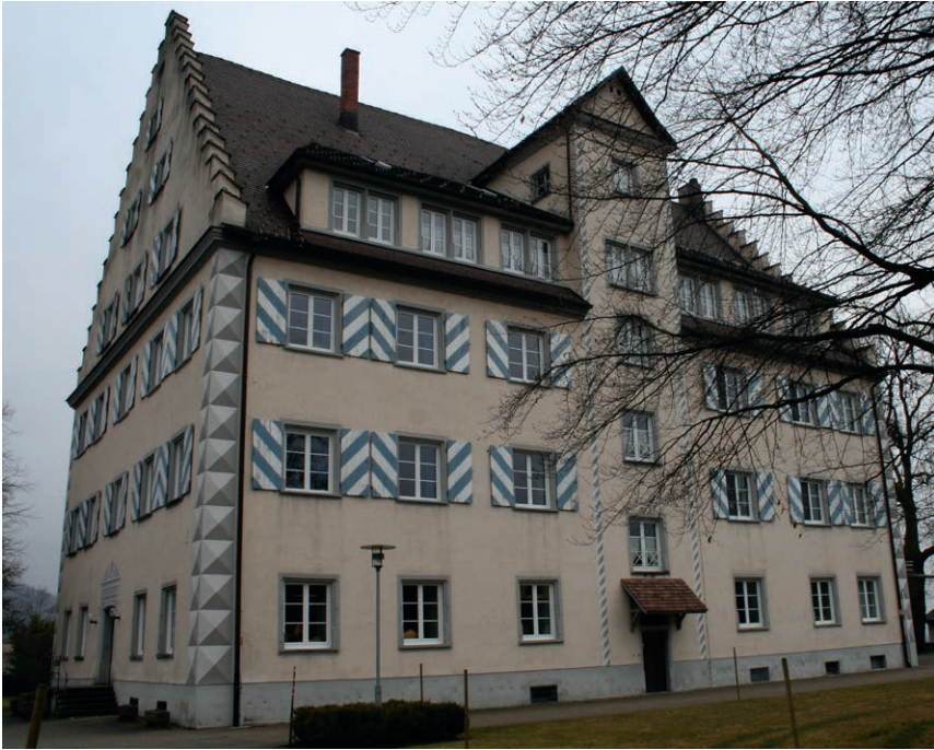
Abbildung 33. Propstei des Klosters St. Blasien in Gurtweil, Westfassade
