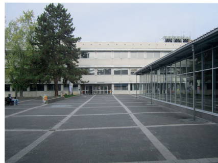
Abb. 11: Universitätsbauleitung Mainz, Fassade des Philosophicums vom Vorhof aus, 1963–1968, Campus der Johannes Gutenberg-Universität Mainz
