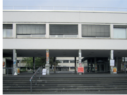
Abb. 5: Universitätsbauleitung Mainz, Frontansicht des Philosophicums von Süden, 1963–1968, Campus der Johannes Gutenberg-Universität Mainz
