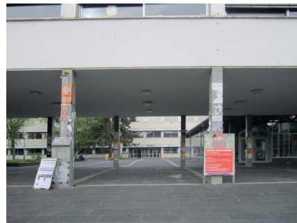
Abb. 7: Universitätsbauleitung Mainz, Frontansicht des Philosophicums von Süden, 1963–1968, Campus der Johannes Gutenberg-Universität Mainz
