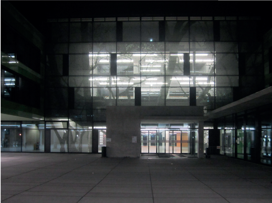
Abb. 3: Kühnl + Schmidt Architekten AG, Vorhoffassade des Georg Forster-Gebäudes bei Nacht, 2010–2013, Campus der Johannes Gutenberg-Universität Mainz
