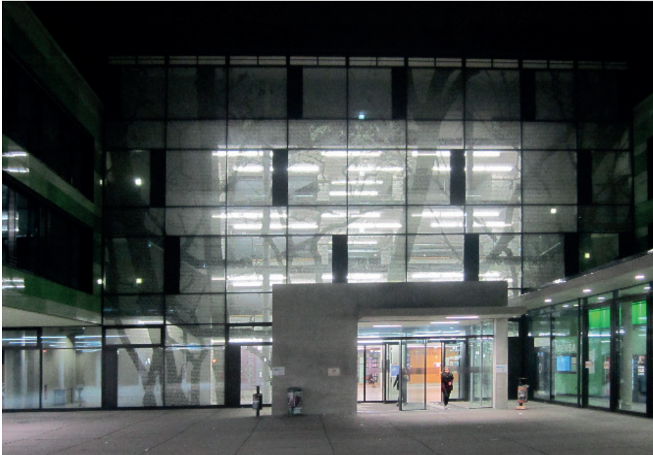
Abb. 37: Kühnl + Schmidt Architekten AG, Vorhoffassade des Georg Forster-Gebäudes bei Nacht, 2010–2013, Campus der Johannes Gutenberg-Universität Mainz
