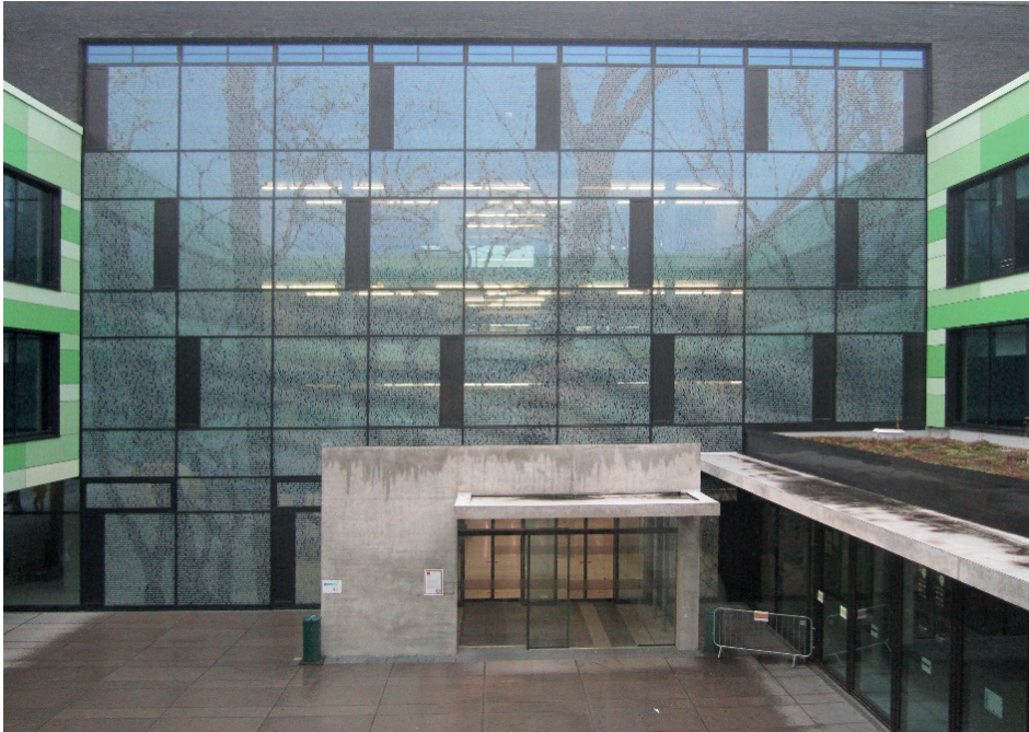
Abb. 41: Kühnl + Schmidt Architekten AG, Blick auf die Vorhoffassade des Georg Forster-Gebäudes aus dem gegenüberliegenden, ersten Stock (Elfenbeinturmperspektive), 2010–2013, Campus der Johannes Gutenberg-Universität Mainz
