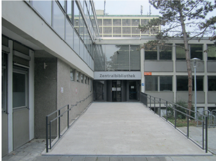
Abb. 14: Mainzer Architektenbüro Heinz Laubach und Günter Müller, Eingangsbereich der Universitätsbibliothek, 1960–1964, Campus der Johannes Gutenberg-Universität Mainz
