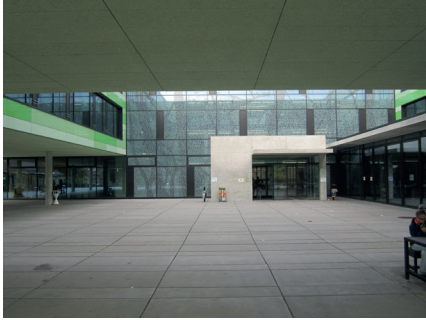
Abb. 8: Kühnl + Schmidt Architekten AG, unter dem Vorbau des Georg Forster-Gebäudes, 2010–2013, Campus der Johannes Gutenberg-Universität Mainz
