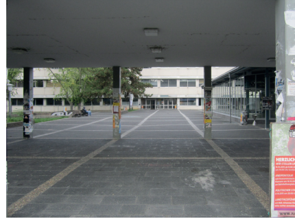
Abb. 9: Universitätsbauleitung Mainz, unter dem Vorbau des Philosophicums, 1963–1968, Campus der Johannes Gutenberg-Universität Mainz
