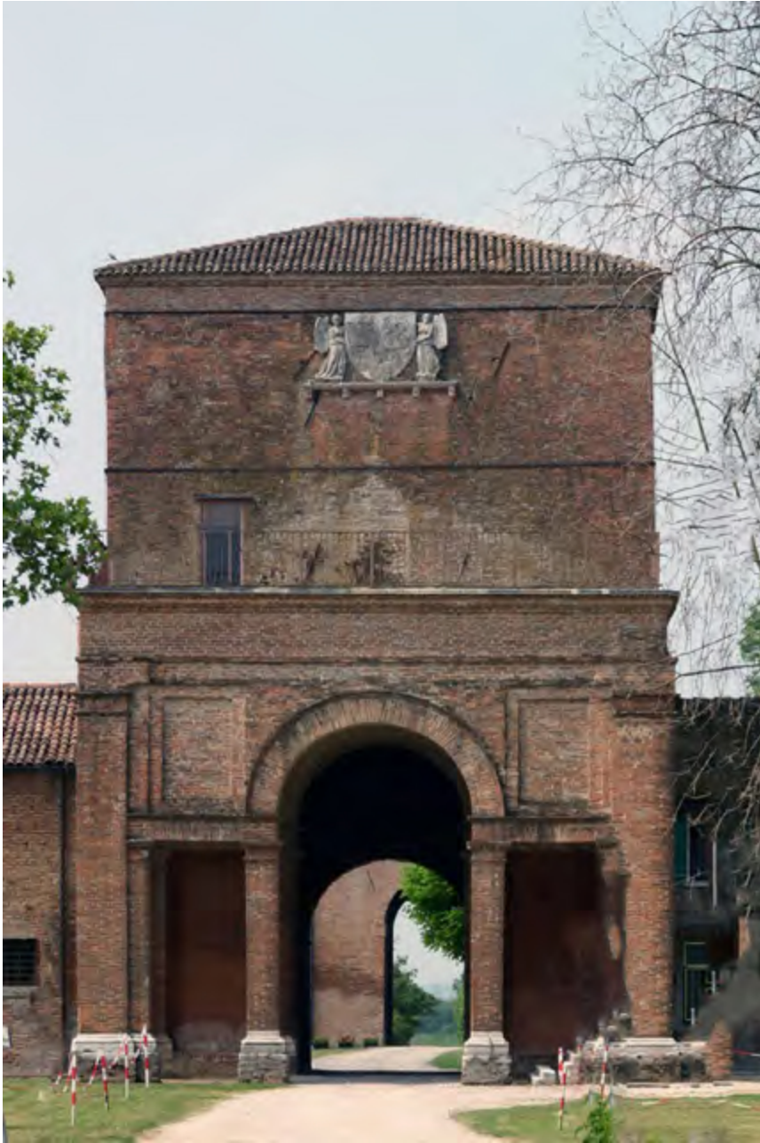
14. Delizia di Belriguardo, Entrance tower.
