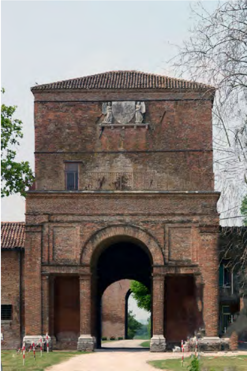
14. Delizia di Belriguardo, Entrance tower.
