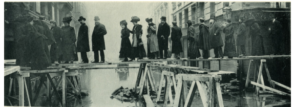
56. Steg während der Flut von 1910.
