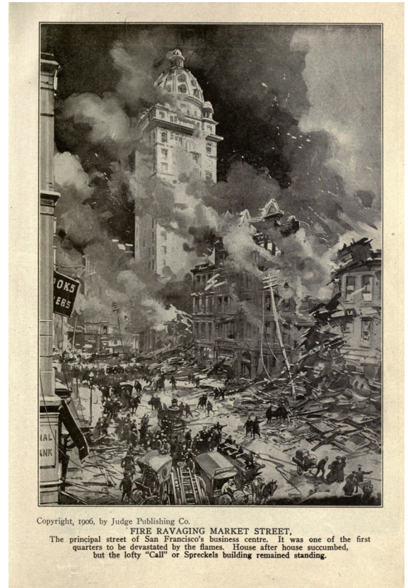
26. „Fire Ravaging Market Street“, in Charles Morris (Hrsg.), The San Francisco Calamity by Earthquake and Fire , 1906. Diese Illustration von Harry Grant Dart erschien zuerst am 3. Mai 1906 als Titelbild von Collier's .
