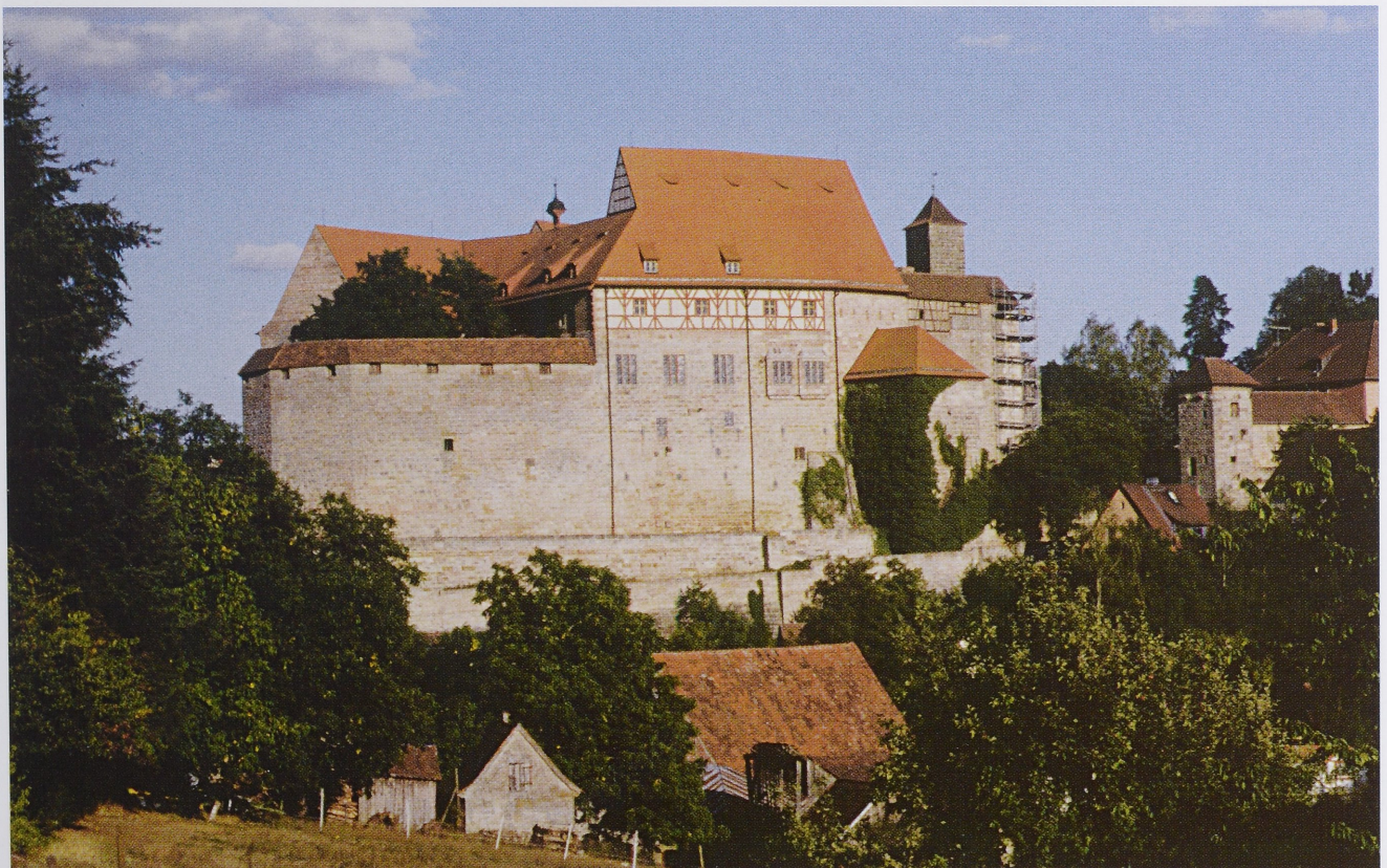
Abb. I (unten) Die Cadolzburg von Westen.
