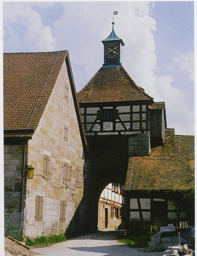
Abb. VIc Das Tor der Vorburg vom Hof aus gesehen, links das ehem. Schulhaus, rechts das ehem. Waschhaus.
