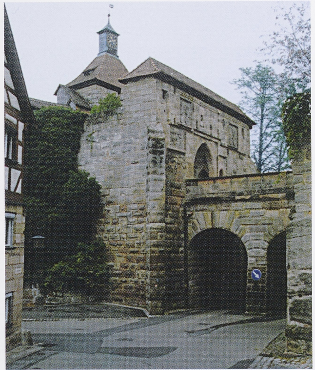
Abb. VIa Das Tor der Vorburg.
