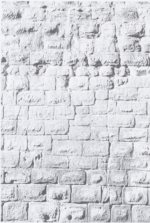
Abb. 45 Die Ringmauer westlich des Tores zeigt anhand schräg verspringender Steinlagen deutlich ihre abschnittsweise Errichtung.
