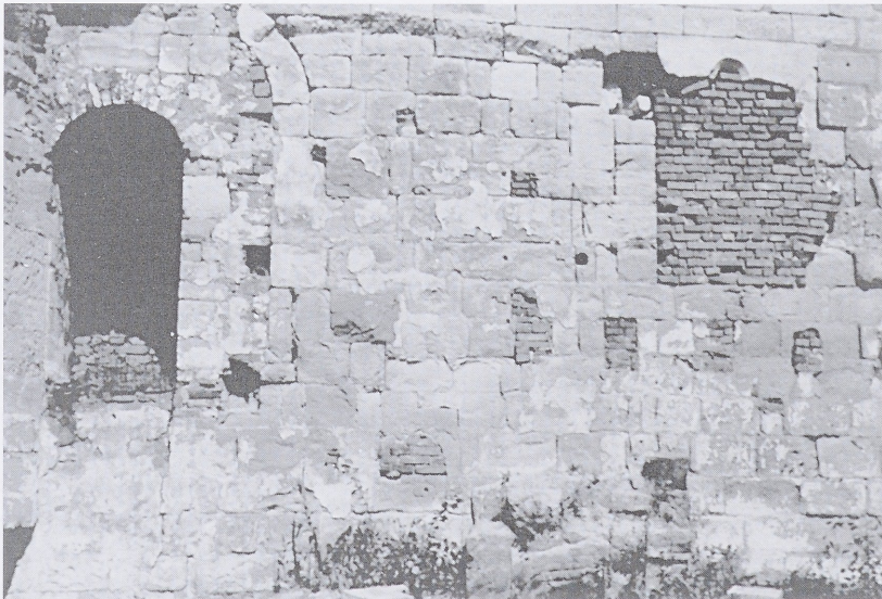
Abb. 60 Die ehemalige Aussenseite des Palas-Obergeschosses, später Ostwand der Oberkapelle. Zustand nach 1945. Die Baubefunde sind heute weitgehend durch Sanierung des Mauerwerks unkenntlich. Gut erkennbar links die ältere Öffnung im Bereich des Emporenzugangs sowie rechts ein Fensterrest.
