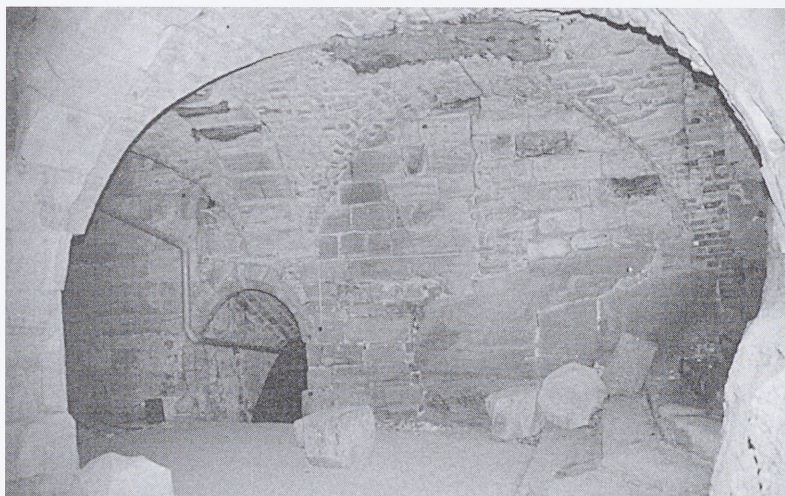
Abb. 65 Gewölbe im Untergeschoß des Gotischen Baus (»Kellerei«) mit sekundärer Wölbung, Blick nach Süden auf den Kellerabgang. Vgl. Abb. 15 (Zustand 1946).
