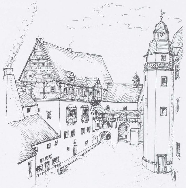
Abb. 51 Der vordere Burghof um 1620. Der Rekonstruktionsversuch zeigt den Kapellenbau mit dem Fachwerkgang, jedoch noch ohne die um 1630 erfolgte Aufstockung. Die Form des Erkers am Alten Schloß ist frei rekonstruiert.
