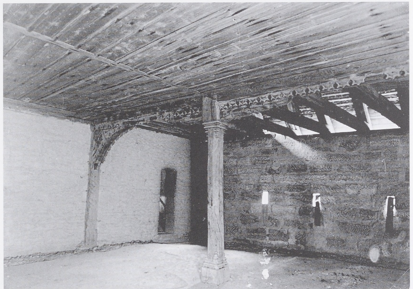
Abb.97 Der südwestliche Raum des Fachwerkgeschosses (Abb. 91: 9). Die grobe Wand aus Mauerwerk stammt vom Abbruch des Fachwerkgeschosses auf dem hier angebauten Folterturm im 18. Jahrhundert. Aufnahme von F. A. Nagel 1938.
