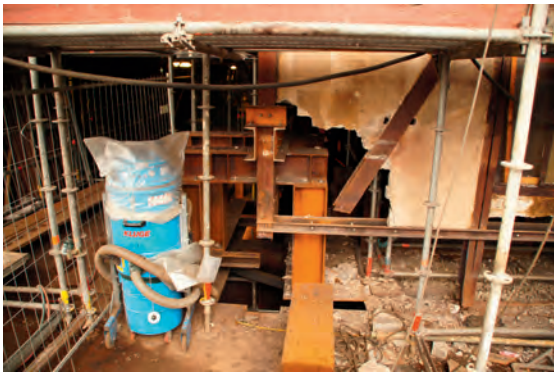
Abb. 9a: Trockengasreinigung I, Stahlbau – Zustand während der Sanierungsmaßnahmen
