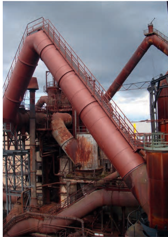
Abb. 4: Komplettaustausch von abgängigen Stahlrohren. Erhaltungsmaßnahmen im industriell-kulturellen Kontext. Hier: Weltkulturerbe Völklinger Hütte (2013)
