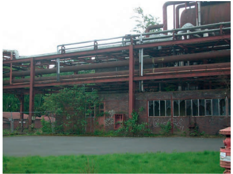
Abb. 2: Zollverein, Kammgebäude, Außenansicht vor Sanierung (2009)
