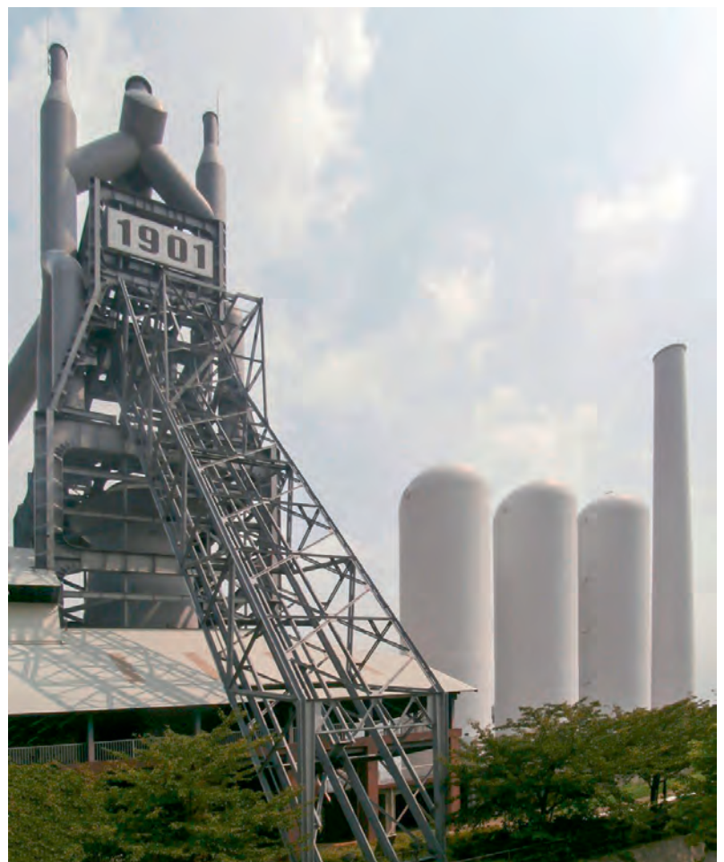
Abb. 2: Yawata Eisen- und Stahlwerk: Higashida Nr. 1 – Nachfolger des ursprünglichen, 1901 angeblasenen Hochofens Nr. 1, bis auf wenige Meter am gleichen Standort (rechts zugehörige Winderhitzer) (2014)
