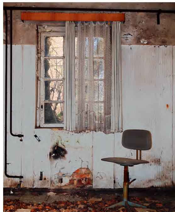
Abb. 4: Zurückgelassener Bürostuhl in einem Betriebsteil des ehemaligen VEB Berlin-Chemie in Adlershof (2017)
