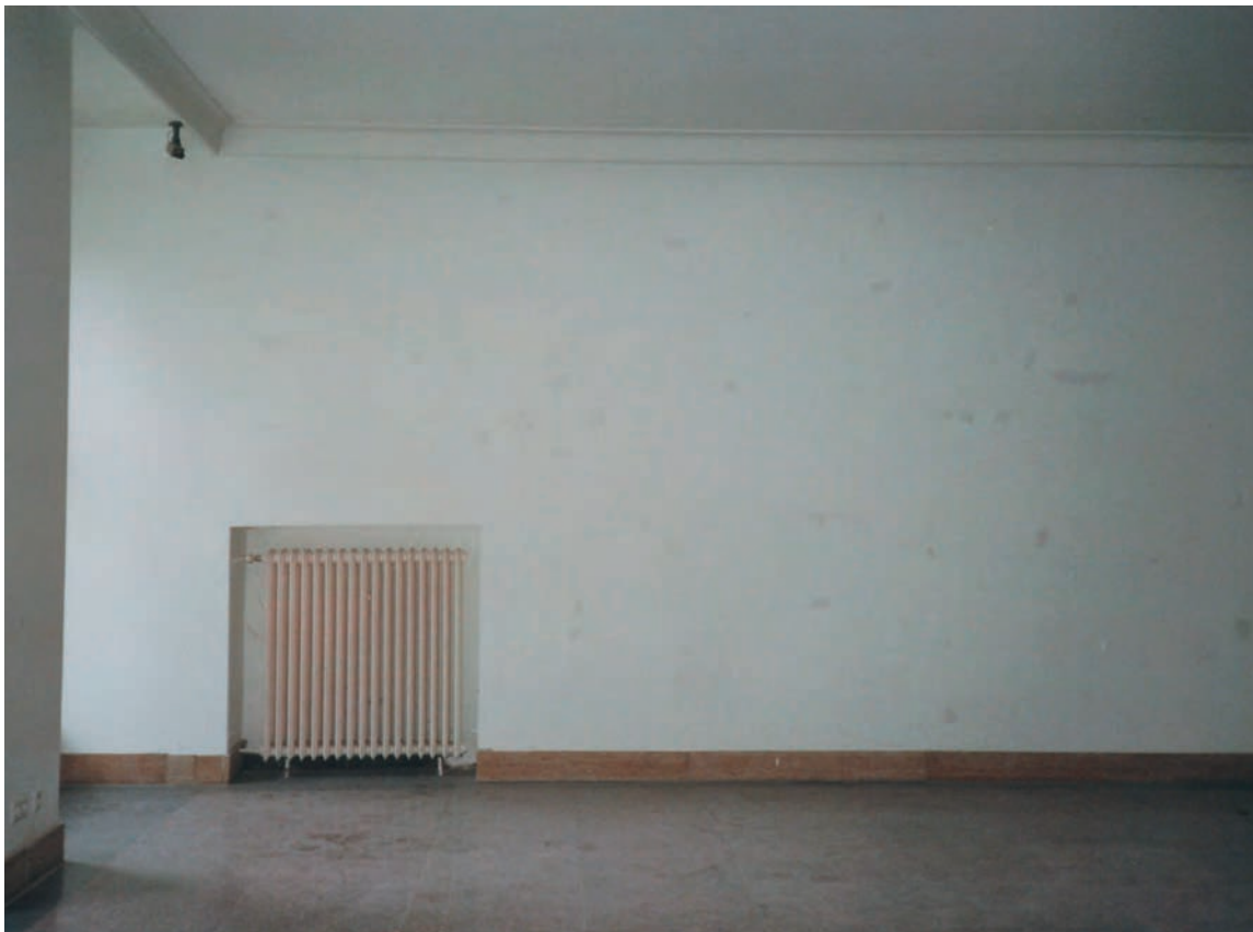
Abb. 3: Wand mit Heizung (2017)
