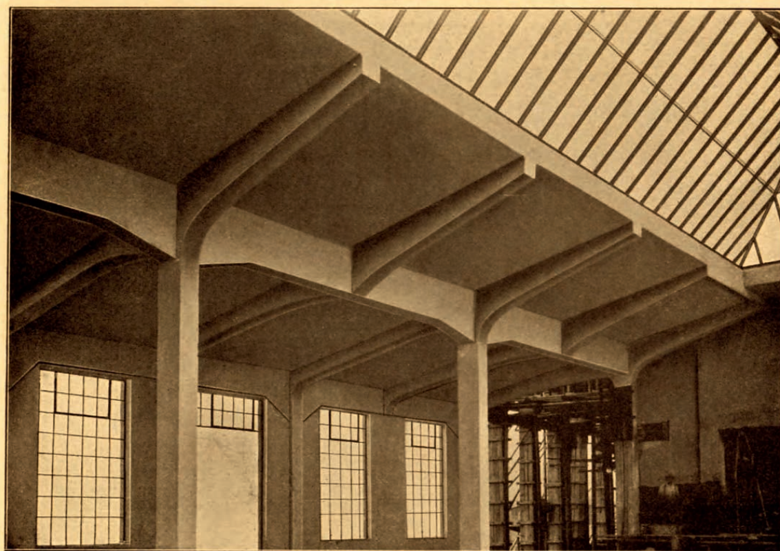
Abbildung Nr. 105. Dachdecke der Schmiede in der Internationalen Baumaschinenfabrik in Neustadt a. d. Hdt.
