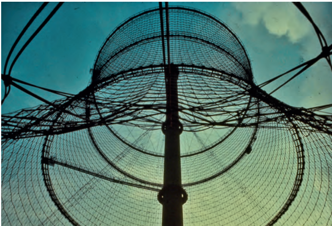
Abb. 2: Kühlturm des AKW Hamm-Uentrop vor Anbringung der Verkleidung (1974)
