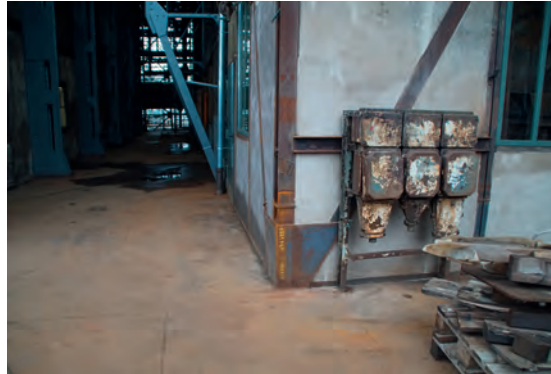
Abb. 9b: Trockengasreinigung I, Stahlbau – Zustand nach Fertigstellung
