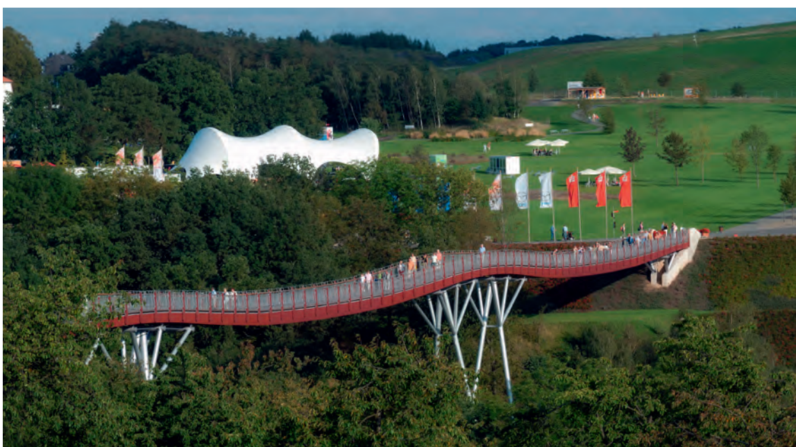
Abb. 3: Die Holzbrücke Drachenschwanz über das Gessetal in der Neuen Landschaft Ronneburg (2007) Fig. 3: The wooden Drachenschwanz bridge over the Gessen valley in the New Ronneburg Landscape
