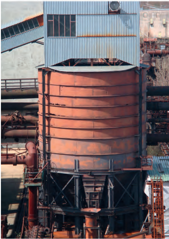
Abb. 3: Restaurierter Behälter mit künstlich aufgebrachtener Patina. Erhaltungsmaßnahmen industriell-kultureller Kontext. Hier: Weltkulturerbe Völklinger Hütte (2013)
