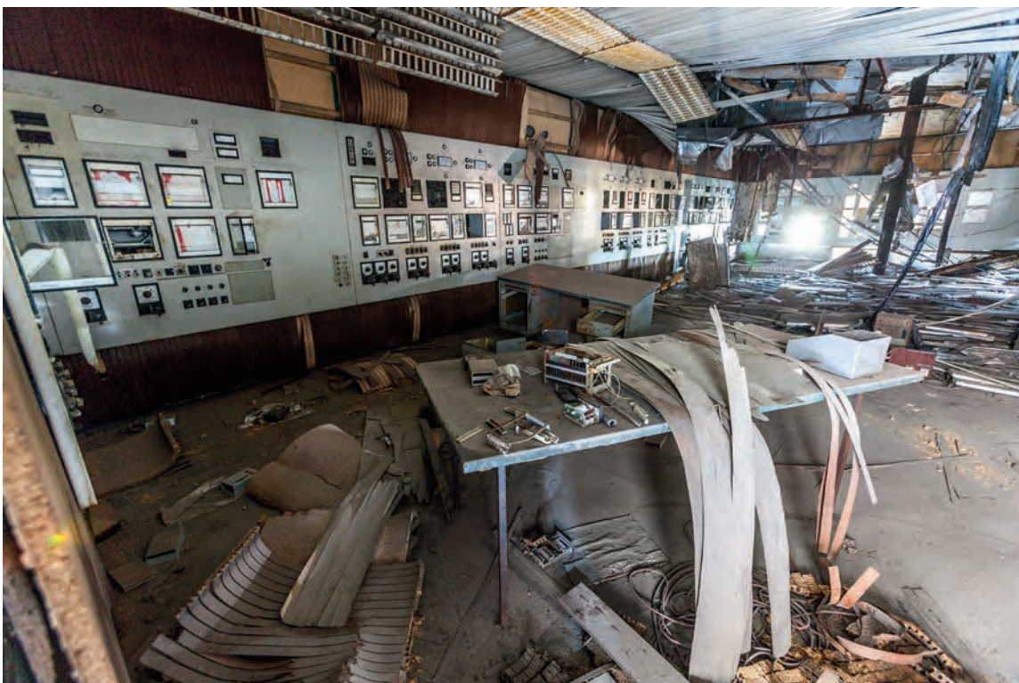
Abb. 10: Hochofenleitstand in der Trockengasreinigung II – Zustand vor der Sicherung des Inventars
