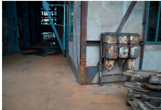
Abb. 9b: Trockengasreinigung I, Stahlbau – Zustand nach Fertigstellung
