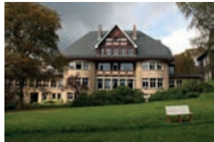
Abb. 211: Albinmüller: Sanatorium Dr. Barner, Braunlage, Neubau (1911–1914): Hauptfassade. Der Zugang zum Bau liegt links (rechts neben der Durchfahrt).
