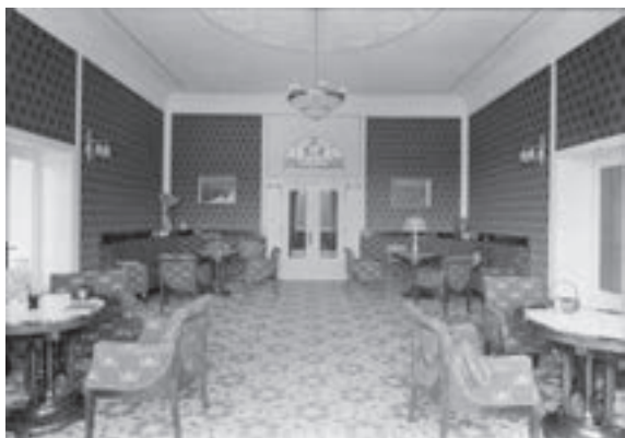
Abb. 229: Albinmüller: Sanatorium Dr. Barner, Braunlage, Neubau (1911–1914): Damenzimmer (Historische Aufnahme)
