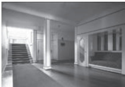
Abb. 219: Albinmüller: Sanatorium Dr. Barner, Braunlage, Neubau (1911–1914): Treppenflur bei den Fremdenzimmern (Historische Aufnahme)
