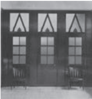
Abb. 249: Albinmüller: Deutsche Vereinsbank Darmstadt (1923): Wand in der Schalterhalle
