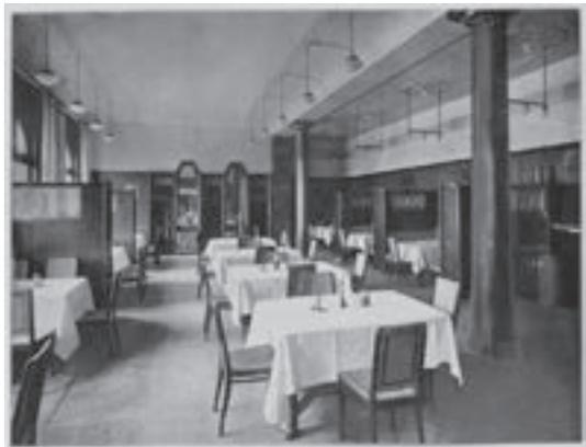
Einen deutlichen Kontrast bildeten Pilaster aus schwarzem Marmor an der Stirnseite sowie die mit dunklem Kupferblech ummantelten Deckenstützen in der Raummitte. Bei letzteren handelte es sich eigentlich um Eisenträger, diese aber offen zu zeigen, im Sinne einer die Konstruktion betonenden Ästhetik, passte nicht in das auf Eleganz ausgerichtete Raumkonzept Albinmüllers. Er ließ diese als klassische Säulen mit angedeuteten Kapitellen und Basen in einem edleren Material verkleiden.
