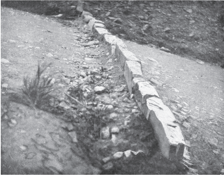
← 8: „Und nun muss man alle 20 Schritte einen Hupfer machen, um die Steindämme zu überwinden, die Abb. 75 genau zeigt“
