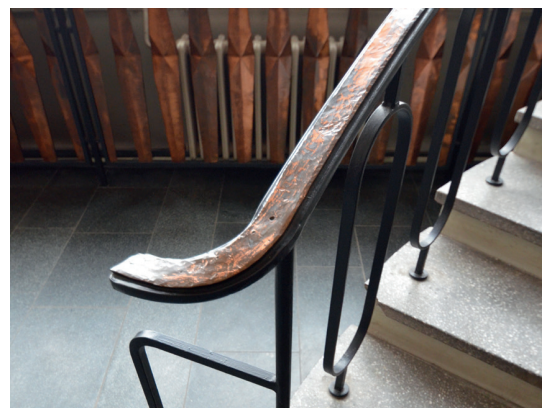
↓ 9: Bezirksparteischule des SED Erfurt, Detail. Die Oberfläche des Handlaufes ist betont handwerklich, mit groben Hammerschlägen gestaltet
