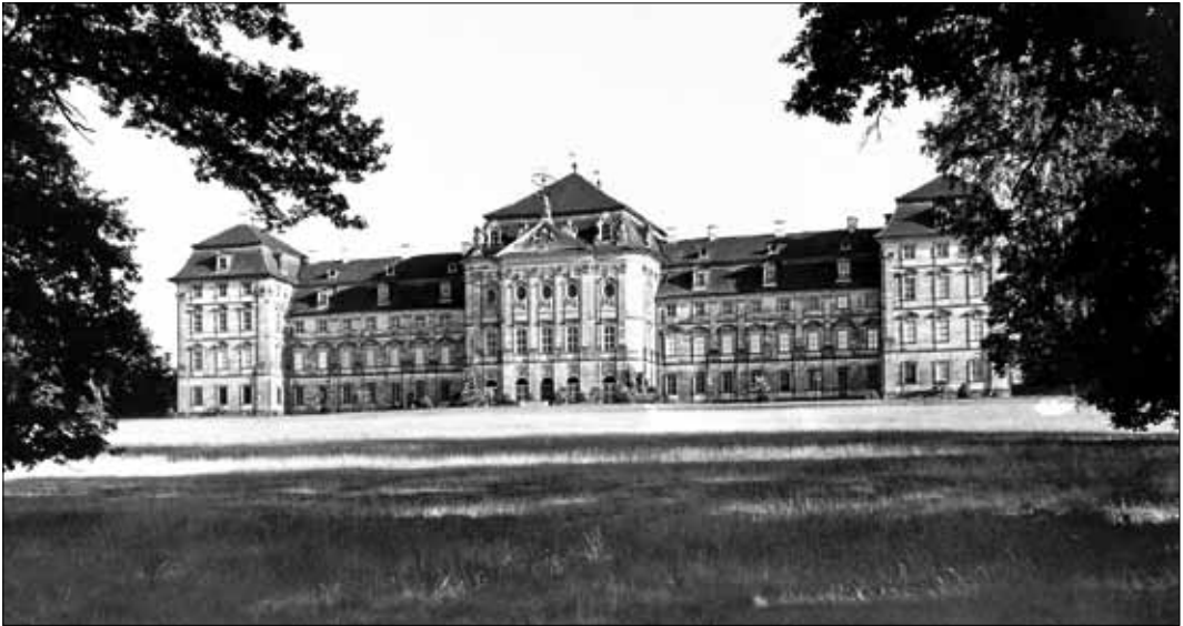
Abb. 5: Pommersfelden, Schloss Weißenstein, Gartenansicht des Schlosses mit der weitgehend steinsichtigen Fassade, die mangels klarer Befunde bei der Restaurierung in den 1970er Jahren beibehalten wurde (Foto: Bayerisches Landesamt für Denkmalpflege)
