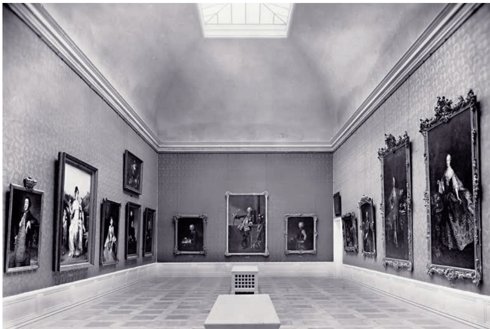
IV Galeriebau, Obergeschoss, Barocksaal (Raum 129), 1935
